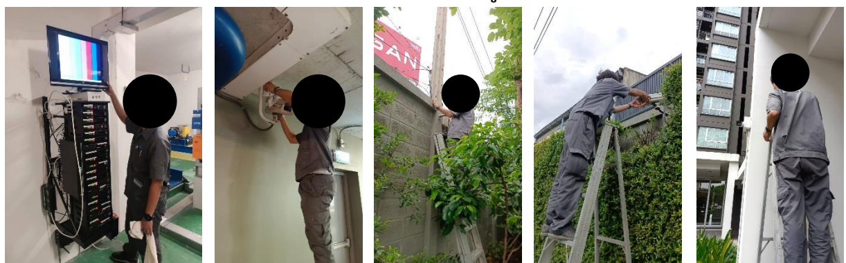
รูปที่ 2-36 ตรวจสอบ ระบบ CCTV รอบโครงการ ทำความสะอาด,ปรับความชัด,ปรับมุมกล้อง
