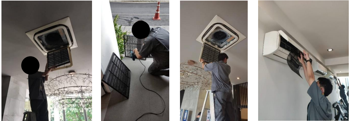
รูปที่ 2-37 ล้างแผ่นกรองและล้างแอร์ส่วนกลาง
