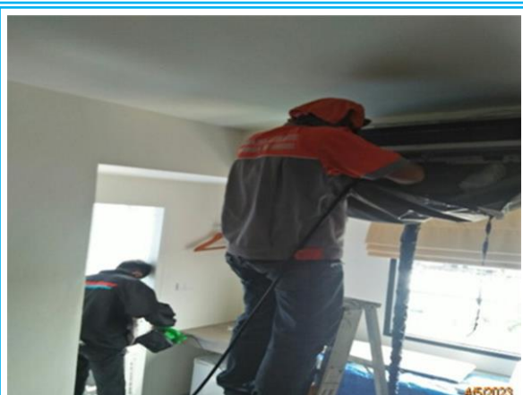
รูปที่ 3-9 ทำความสะอาดเครื่องปรับอากาศทุก 6 เดือน
