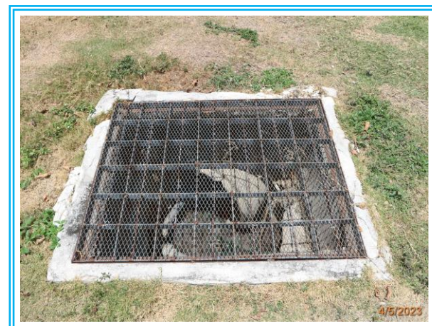
รูปที่ 3-26 สภาพท่อระบายน้ำบนถนนซอยหัวหิน 51 ช่วงที่เชื่อมต่อกับท่อระบายน้ำของโครงการ
