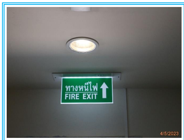
รูปที่ 3-41 ป้ายบอกทางหนีไฟ และไฟส่องสว่างฉุกเฉิน
