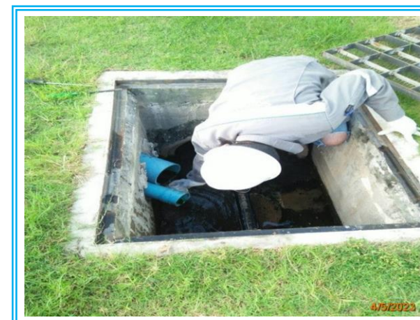
รูปที่ 3-25 การเก็บเศษตะกอนออกจากบ่อพักน้ำสุดท้ายของโครงการ
