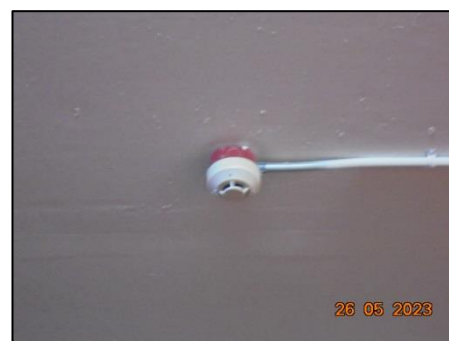
รูปที่ 37 Heat Detector ภายในอาคารชุดคิวหลังสวน
