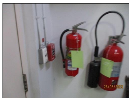
รูปที่ 32 ถังดับเพลิงชนิดน้ำยาเหลวระเหย บีเอฟ 2000
