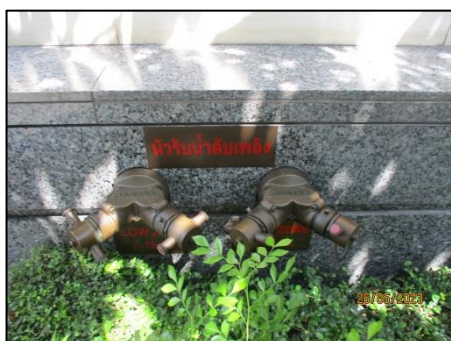
รูปที่ 30 หัวรับน้ำดับเพลิงภายนอกอาคารชุดคิวหลังสวน
