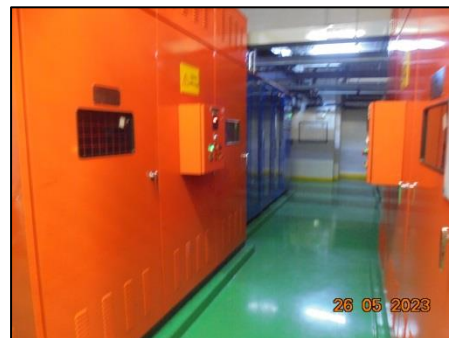
รูปที่ 23 ระบบไฟฟ้า Transformer ชนิด Dry Type Cast Resin ขนาด 2,000 KVA จำนวน 2 ชุด
