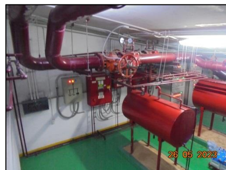
รูปที่ 28 ระบบท่อเย็น ใช้ท่อเย็นที่มีขนาดเส้นผ่านศูนย์กลาง 6 นิ้ว สำหรับพื้นที่ Low Zone และ High Zone
