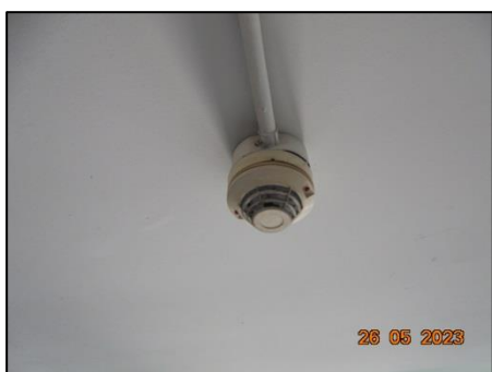
รูปที่ 37 Heat Detector ภายในอาคารชุดคิวหลังสวน
