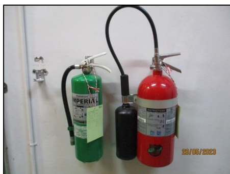
รูปที่ 32 (ต่อ) ถังดับเพลิงชนิดน้ำยาเหลวระเหย บีเอฟ 2000
