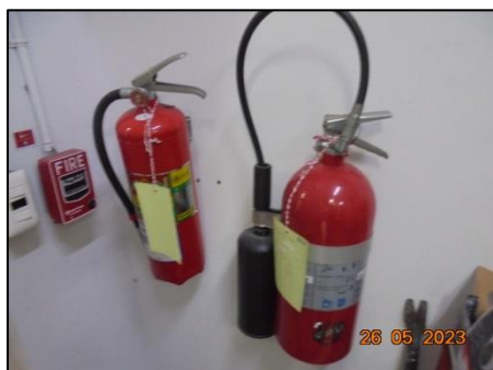
รูปที่ 32 ถังดับเพลิงชนิดน้ำยาเหลวระเหย บีเอฟ 2000
