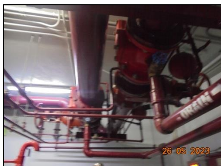
รูปที่ 28 ระบบท่อเย็น ใช้ท่อเย็นที่มีขนาดเส้นผ่านศูนย์กลาง 6 นิ้ว สำหรับพื้นที่ Low Zone และ High Zone
