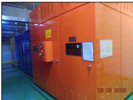
รูปที่ 23 ระบบไฟฟ้า Transformer ชนิด Dry Type Cast Resin ขนาด 2,000 KVA จำนวน 2 ชุด
