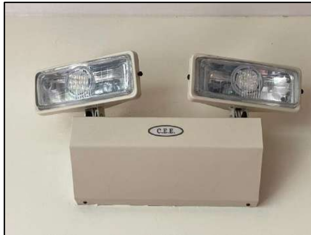
รูปที่ 9 ไฟส่องสว่างฉุกเฉิน
