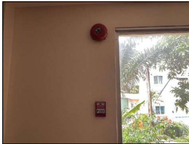
รูปที่ 11 กริ่งสัญญาณเตือนภัย (Alarm Bell)
