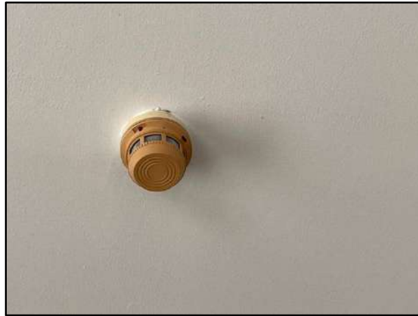
รูปที่ 10 เครื่องตรวจจับควัน (Smoke Detector)
