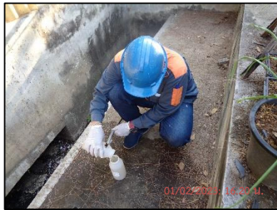
บ่อดักน้ำเสียก่อนเข้าระบบบำบัดน้ำเสียรวม
