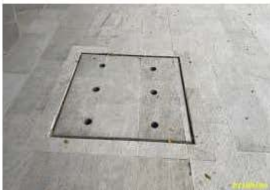
ท่อระบายน้ำ และบ่อพักน้ำ
