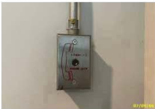
โทรศัพท์ฉุกเฉิน (Telephone Jack)
