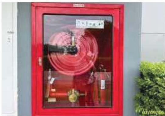
ตู้เก็บสายฉีดน้ำดับเพลิงพร้อมอุปกรณ์ (FHC)
