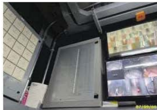
แผงควบคุม (Fire Alarm Control Panel)
