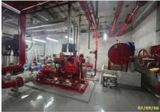
เครื่องสูบน้ำดับเพลิง (Fire Pump)
