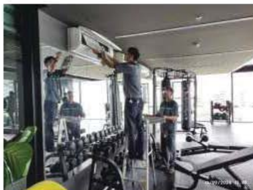
ช่างดำเนินการทำความสะอาดเครื่องปรับอากาศพื้นที่ส่วนกลาง
