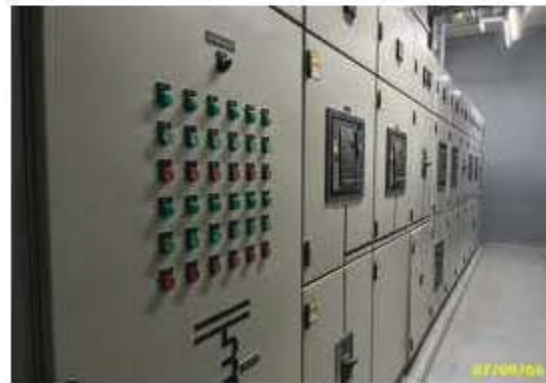
ตู้ควบคุมระบบไฟฟ้าหลัก
