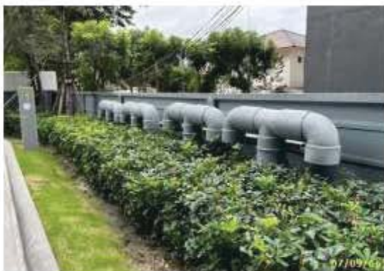
บ่อดินกำจัดมีเทน (Methane) และท่อกำจัด Aerosol
