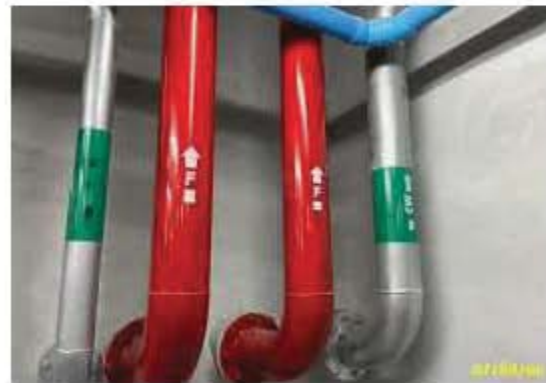
ระบบท่อน้ำดับเพลิง (Stand Pipe)
