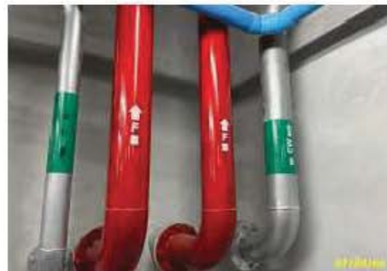
ระบบท่อน้ำ (Stand Pipe)
