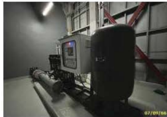
ถังเก็บน้ำชั้นตาดฟ้า พร้อมเครื่องปั้มน้ำชั้นตาดฟ้า
