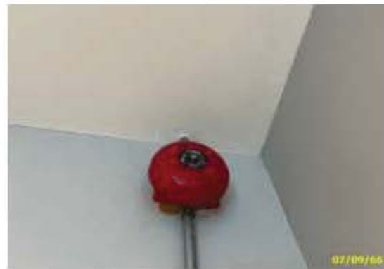
กริ่งสัญญาณเตือนอัคคีภัย (Fire Alarm Bell)
