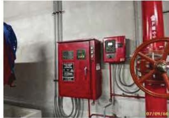
เครื่องสูบน้ำดับเพลิง (Fire Pump)
