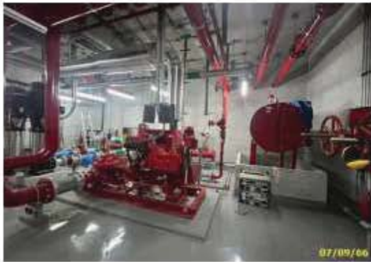
เครื่องสูบน้ำดับเพลิง (Pire Pump)
