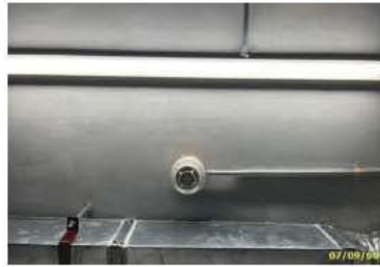
เครื่องตรวจจับความร้อน (Heat Detector)
