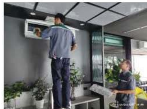
ช่างดำเนินการทำความสะอาดเครื่องปรับอากาศพื้นที่ส่วนกลาง
