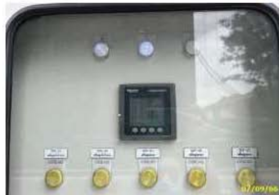
มิเตอร์ไฟฟ้าระบบบำบัดน้ำเสีย
