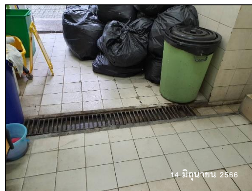
ภาพที่ 20 รังระบายน้ำภายในห้องพักมูลฝอย
