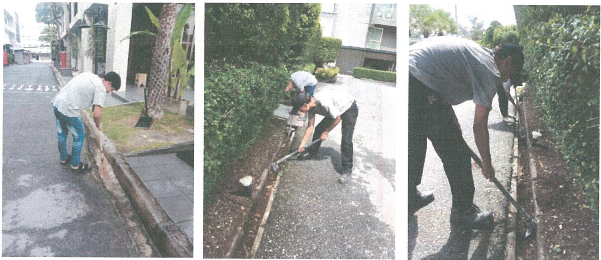
รูปภาพที่ 2.18 การขุดลอกรางระบายน้ำ
