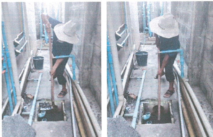
รูปภาพที่ 2.27 การขุดลอกตะกอน
