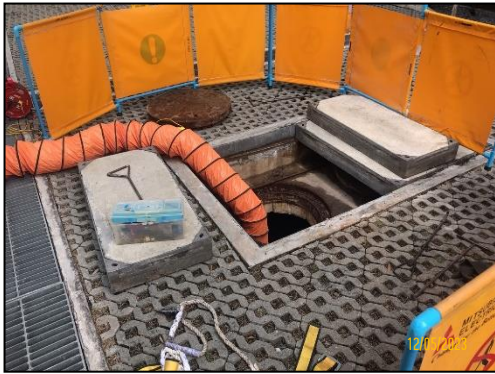
รูปที่ 2-19 การตั้งกรวยเมื่อมีการเปิดฝาระบบบำบัดน้ำเสีย
