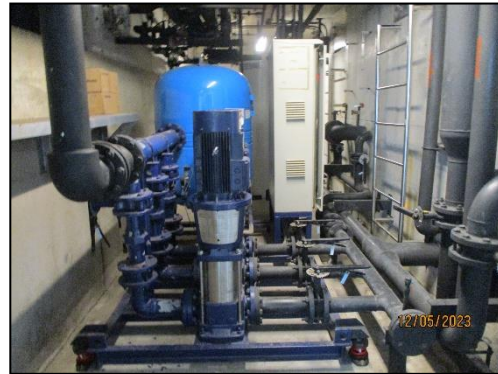
รูปที่ 2-20 ระบบสูบน้ำในอาคาร ซึ่งทำหน้าที่สูบน้ำโดยไม่ได้ดึงน้ำเข้ามาจากท่อประปาโดยตรง และควบคุมการจ่ายน้ำด้วยระบบตั้งเวลา
