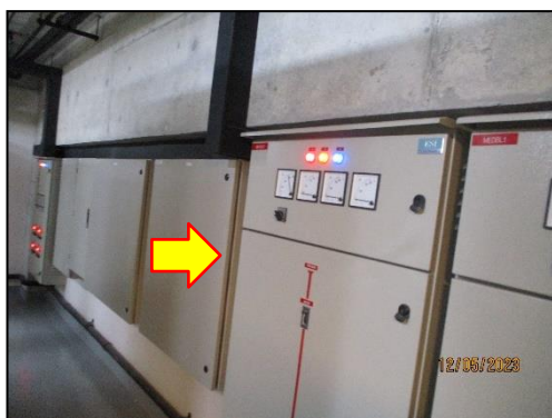
รูปที่ 2-47 หม้อแปลงชนิด Dry Type ขนาด 1,250 KVA จำนวน 2 ชุด สำหรับแปลงไฟฟ้าแรงสูง เพื่อจ่ายไปยัง Load ต่าง ๆ (2)
