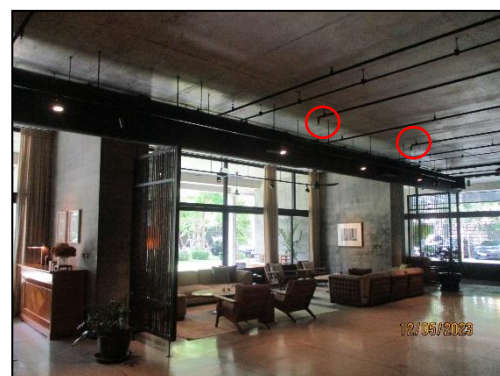
บริเวณพื้นที่ส่วนกลาง รูปที่ 2-66 ระบบหัวจ่ายน้ำดับเพลิงอัตโนมัติ (Sprinkler System) ทุกชั้นอาคาร (1)
