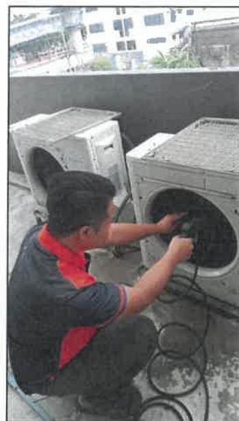
รูปที่ 52 การล้างเครื่องปรับอากาศพื้นที่ส่วนกลางของโครงการ
