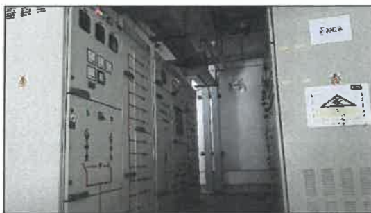
รูปที่ 17 ห้องควบคุมระบบไฟฟ้า (MDB)
