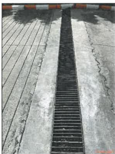
รูปที่ 10 รางระบายน้ำของโครงการ
