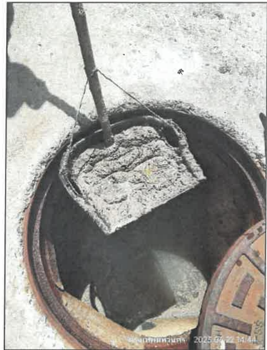
รูปที่ 38 การตักตะกอนและกำจัดไขมัน
