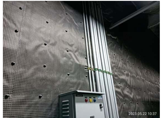
รูปที่ 3-10 ห้อง generator มีการบุวัสดุกันเสียงไม่ให้มีเสียงดังรบกวนออกไปภายนอก
