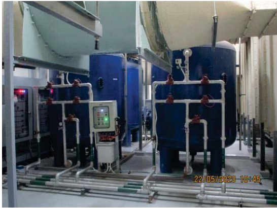
รูปที่ 3-27 ระบบกรองน้ำเสียจากระบบบำบัด
