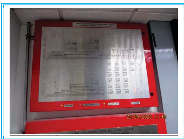
รูปที่ 3-47 แผงควบคุมระบบสัญญาณแจ้งเหตุเพลิงไหม้
