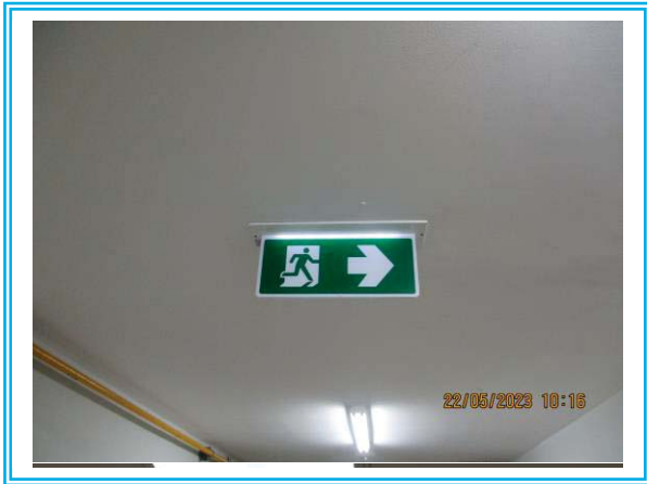
รูปที่ 3-45 ป้ายบอกทางหนีไฟ (Fire Exit Light) บริเวณต่างๆ ภายในโครงการ
