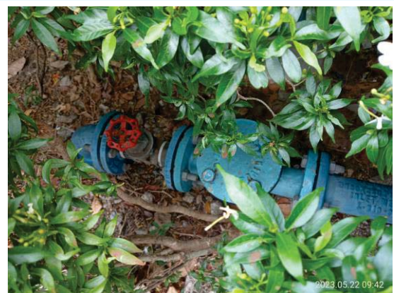
รูปที่ 3-20 การเชื่อมต่อน้ำประปาของโครงการกับท่อประปาหลักริมถนนเจริญกรุง
