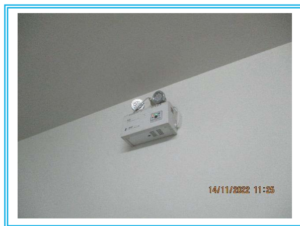
รูปที่ 3-53 การติดตั้งไฟฉุกเฉิน (Emergency Light) ตามจุดต่างๆ ภายในอาคาร
