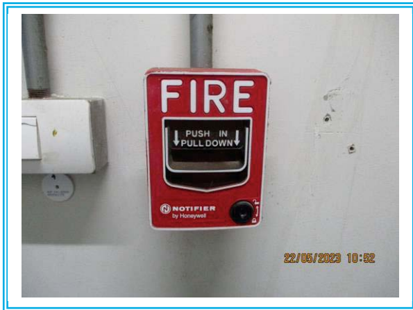
รูปที่ 3-48 ชุดกดแจ้งเหตุ (Manual Pull Down Station)
