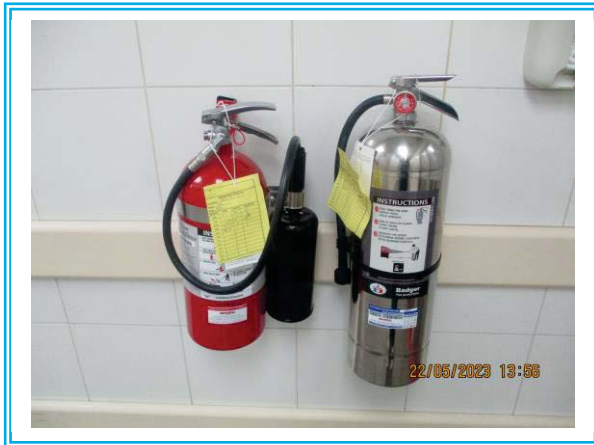
รูปที่ 3-43 การติดตั้งถังดับเพลิงแบบมือถือ บริเวณจุดต่างๆ ภายในอาคาร
