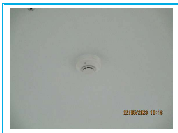
รูปที่ 3-50 การติดตั้งเครื่องตรวจจับควันและเครื่องตรวจจับความร้อน
