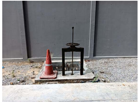
รูปที่ 3-30 บ่อหน่วงน้ำสำหรับพื้นที่รับน้ำ A
