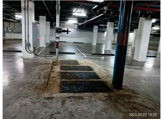
รูปที่ 3-28 ระบบถังดักไขมัน
