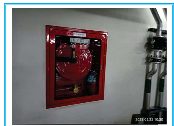
รูปที่ 3-44 การติดตั้งถังดับเพลิงในตู้สายฉีดน้ำดับเพลิง บริเวณลานจอดรถ และพื้นที่ส่วนกลาง
