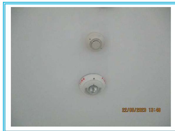
รูปที่ 3-49 อุปกรณ์ส่งสัญญาณแจ้งเหตุ (Alarm Bell)
