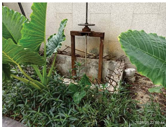
รูปที่ 3-31 บ่อหน่วงน้ำสำหรับพื้นที่รับน้ำ B อยู่ระหว่างปรับปรุงชั่วคราว
