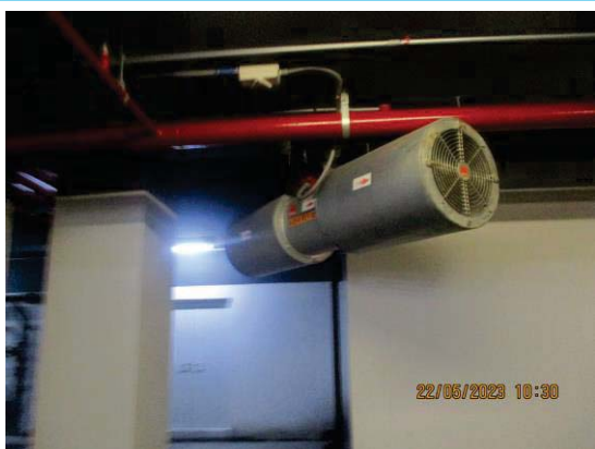
รูปที่ 3-9 ระบบระบายอากาศบริเวณลานจอดรถ
