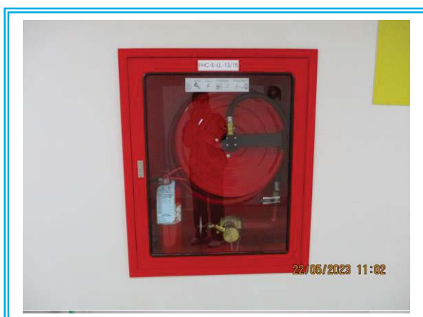
รูปที่ 3-44 การติดตั้งถังดับเพลิงในตู้สายฉีดน้ำดับเพลิง บริเวณลานจอดรถ และพื้นที่ส่วนกลาง
