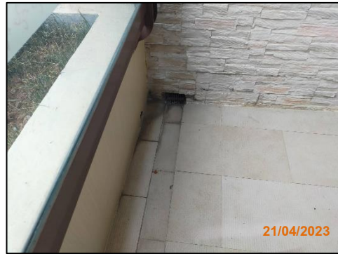
รูปที่ 2-24 รางระบายน้ำภายในอาคาร
