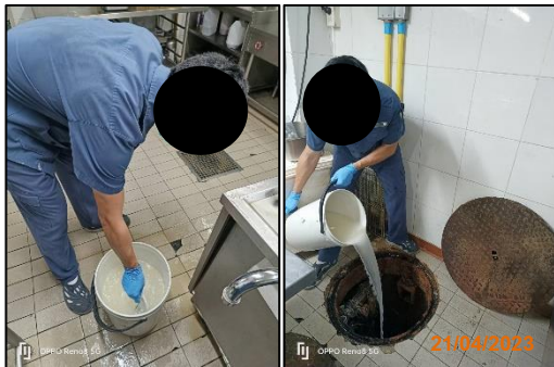
รูปที่ 2-25 การดูแลทำความสะอาดบ่อตกไขมัน
