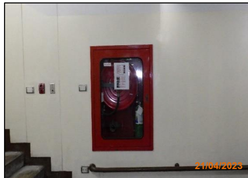
รูปที่ 2-38 ตู้เก็บอุปกรณ์ดับเพลิงภายในอาคาร
