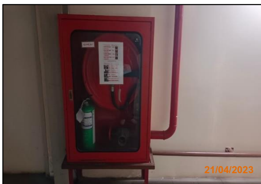
รูปที่ 2-38 ตู้เก็บอุปกรณ์ดับเพลิงภายในอาคาร
