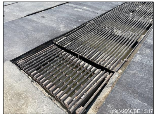
ภาพที่ 38 บ่อคัดดินจากการล้างล้อ
