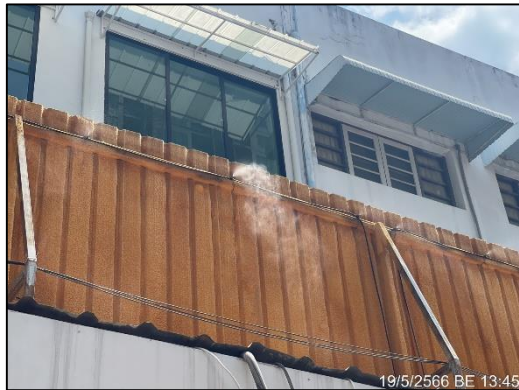
ภาพที่ 17 สเปรย์น้ำบริเวณรั้ว Metal Sheet
