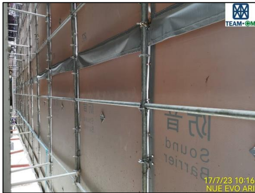
ภาพที่ 95 ติดตั้ง Sound Barrier ป้องกันเสียง
