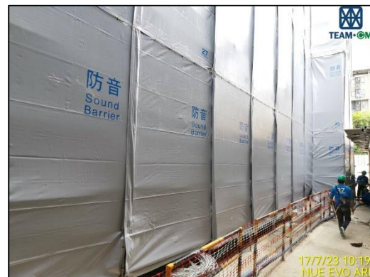
ภาพที่ 95 ติดตั้ง Sound Barrier ป้องกันเสียง
