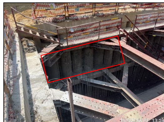
ภาพที่ 6 กำแพงกันดิน (Pile Wall)
