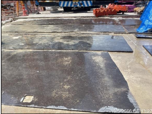
ภาพที่ 21 แผ่นเหล็กปูบริเวณรถวิ่งผ่าน
