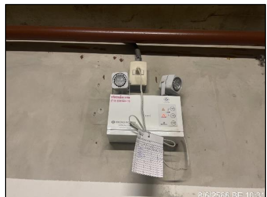
ภาพที่ 16 ระบบไฟฟ้าฉุกเฉิน
