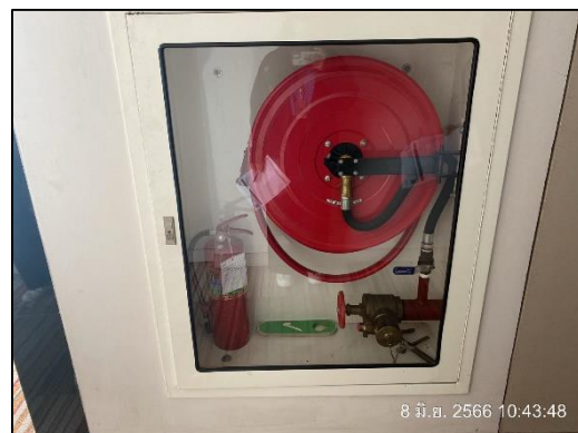
ภาพที่ 26 ตู้เก็บสายฉีดน้ำดับเพลิง
