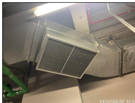
ภาพที่ 38 พัดลมระบายอากาศในห้องเครื่องกำเนิดไฟฟ้า
