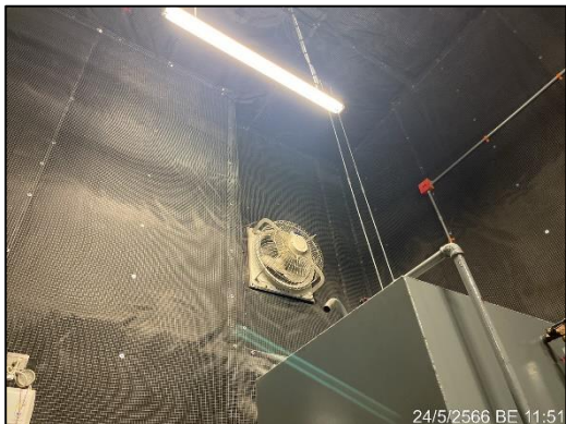
ภาพที่ 39 พัฒนาระบายอากาศในห้องหม้อแปลงไฟฟ้า
