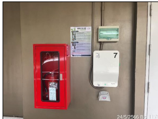
ภาพที่ 34 ตู้อุปกรณ์ดับเพลิง
