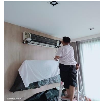
ภาพที่ 2.2-51 การทำความสะอาดเครื่องปรับอากาศ
