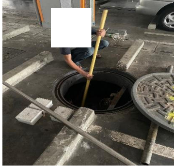
ภาพที่ 2.2-25 การขุดลอกตะกอนบ่อพักน้ำ
