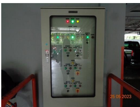
ภาพที่ 2.2-8 ระบบมอเตอร์ไฟฟ้าสำหรับ ระบบบำบัดน้ำเสีย
