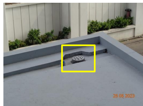
ภาพที่ 2.2-54 การใช้ตะแกรงครอบรูท่อระบายน้ำ
