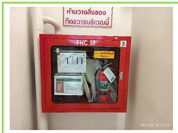
รูปที่ 3-48 ตู้เก็บสายดับเพลิง
