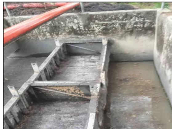
รูปที่ 28 การตักแกลบและขยะออกจากตะแกรง
