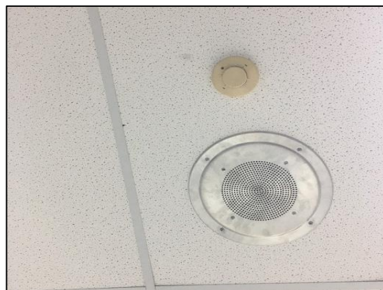
รูปที่ 48 เครื่องตรวจจับควัน (Smoke Detector)
