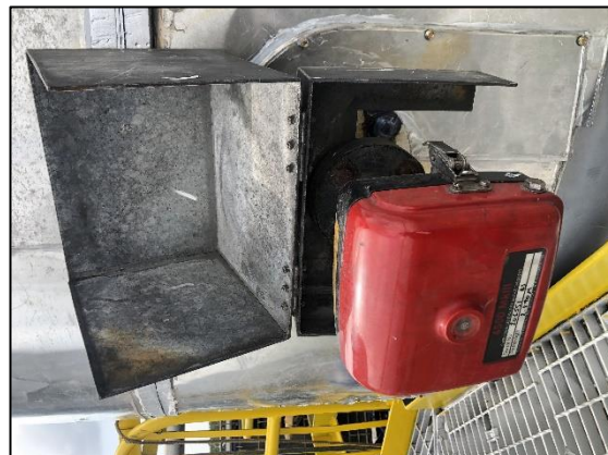
รูปที่ 47 อุปกรณ์ตรวจวัดฝุ่นละออง (Dust Detector)
