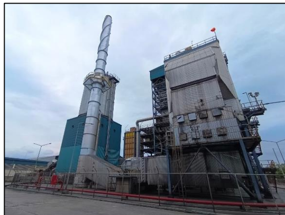
รูปที่ 3 เครื่องดักจับฝุ่น (ESP) ชนิดไฟฟ้าสถิต
