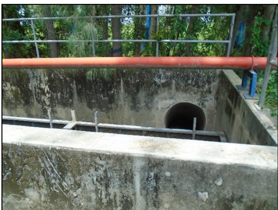
รูปที่ 29 การสูบน้ำจากร่องระบายน้ำไปบ่อเก็บน้ำดิบ (Raw Water Reservoir)
