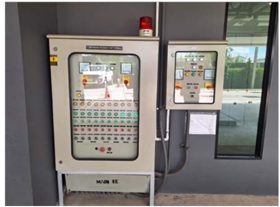
รูปที่ 2-48 ตู้ควบคุมระบบบำบัดน้ำเสีย
