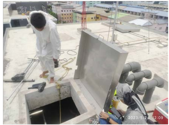
รูปที่ 2-25 การล้างถังเก็บสำรองน้ำ
