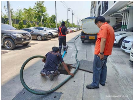
รูปที่ 2-23 สูบตะกอน
