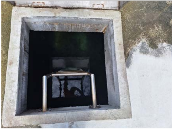
รูปที่ 2-11 ถังเก็บน้ำตาตฟ้า
