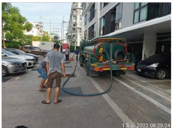
รูปที่ 2-23 สูบตะกอน
