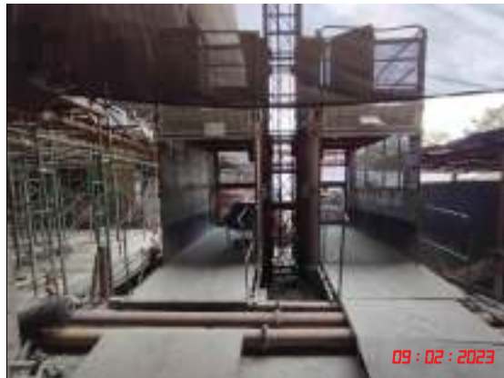
รูปที่ 30 การติดตั้งลิฟต์ขนส่งวัสดุก่อสร้าง
