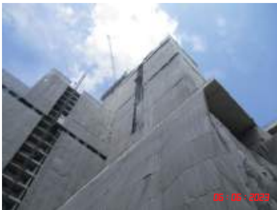
รูปที่ 8 การติดตั้ง Mesh Sheet คลุมตัวอาคาร
