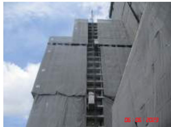
รูปที่ 8 การติดตั้ง Mesh Sheet คลุมตัวอาคาร
