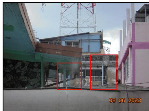
รูปที่ 10 ติดสปริงเกอร์พ่นละอองน้ำรอบบริเวณพื้นที่ก่อสร้าง
