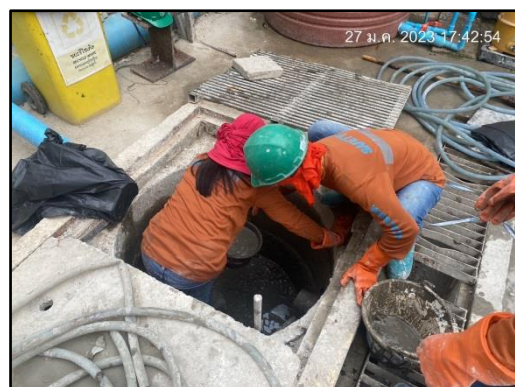
รูปที่ 39 ขุดลอกตะกอนดิน
