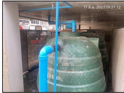
รูปที่ 35 ระบบบำบัดน้ำเสียสำเร็จรูป
