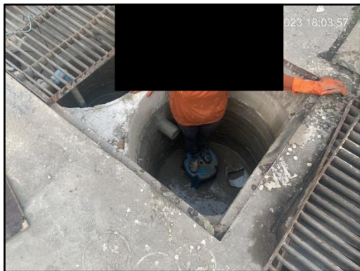
รูปที่ 38 ปอดตกตะกอนและปอดพักน้ำทิ้ง
