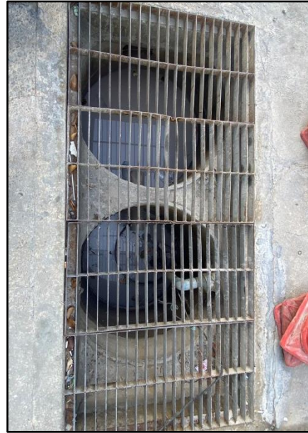
รูปที่ 38 ปอดตกตะกอนและปอดพักน้ำทิ้ง
