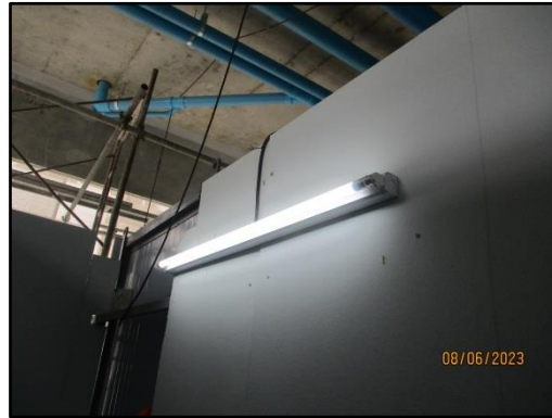
รูปที่ 46 การติดตั้งหลอดไฟฟ้าประหยัดพลังงาน (LED)
