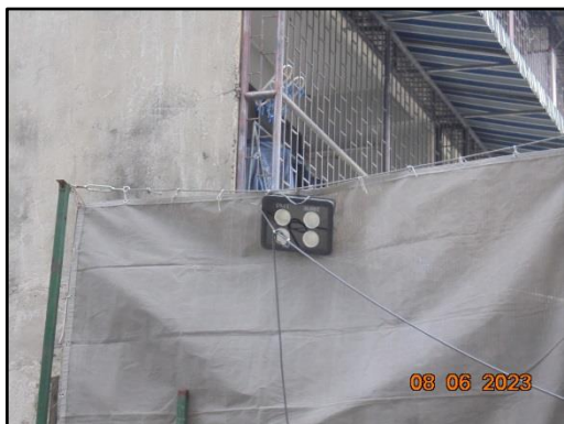
รูปที่ 47 การติดตั้งสปอร์ตไลท์
