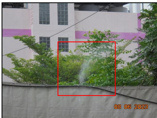
รูปที่ 10 ติดสปริงเกอร์พ่นละอองน้ำรอบบริเวณพื้นที่ก่อสร้าง
