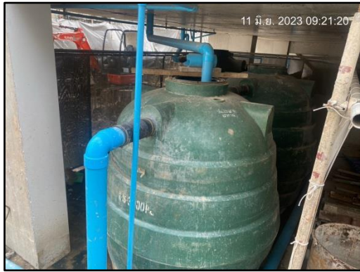
รูปที่ 35 ระบบบำบัดน้ำเสียสำเร็จรูป
