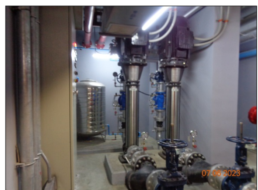
รูปที่ 9 ถังสำรองน้ำใช้ ฝาถัง วาล์วเปิดน้ำประปา สภาพน้ำในถัง และปั๊มสูบน้ำดับเพลิง
