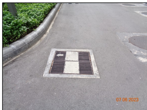
รูปที่ 29 ท่อระบายน้ำคอนกรีตเสริมเหล็กรอบพื้นที่โครงการ
