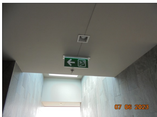
รูปที่ 44 ระบบเตือนภัยและป้องกันอัคคีภัยของโครงการ
