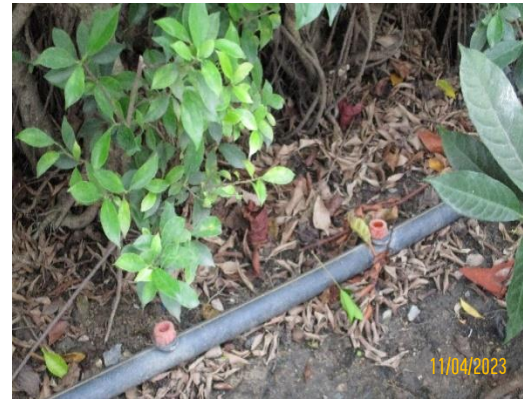
รูปที่ 2-14 การนำน้ำเสียที่ผ่านการบำบัดแล้วมาใช้รดน้ำต้นไม้ภายในพื้นที่โครงการฯ
