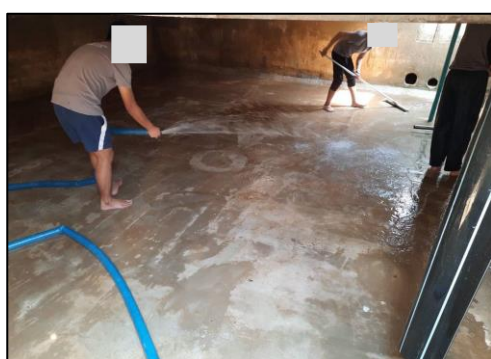
รูปที่ 3-28 การตรวจสอบและทำความสะอาดถังสำรองน้ำใช้
