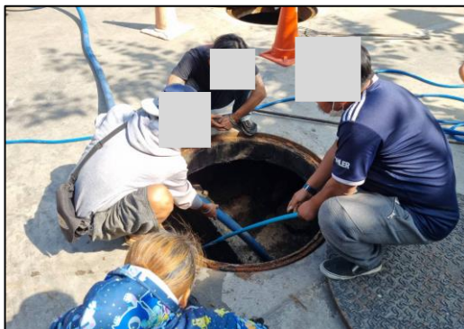
รูปที่ 2-36 การสูบน้ำในบ่อเกรอะ
