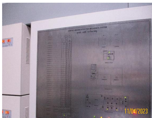
รูปที่ 3-8 แผงวงจรอิเล็กทรอนิกส์สำหรับควบคุมระบบน้ำใช้ของโครงการฯ
