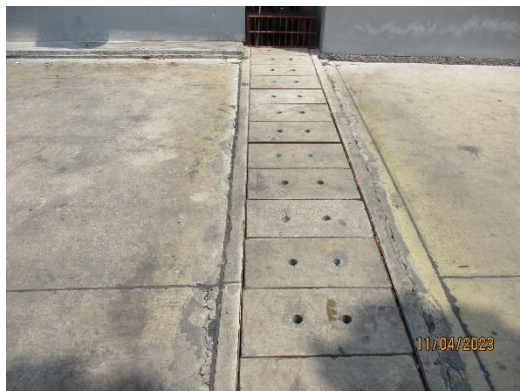
รูปที่ 3-20 รางระบายน้ำ และท่อระบายน้ำของโครงการฯ
