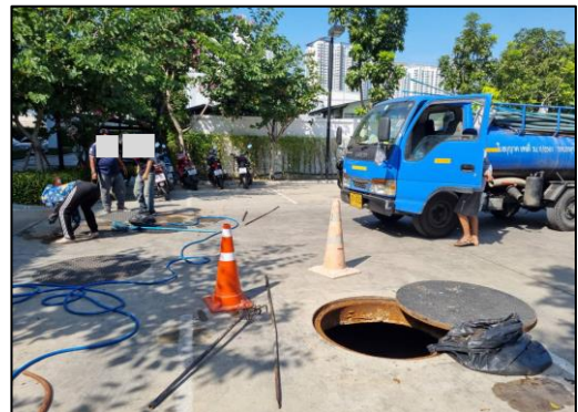
รูปที่ 2-36 การสูบน้ำในบ่อเกรอะ
