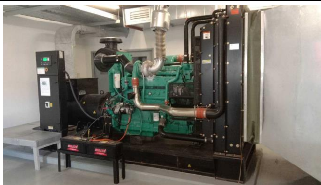
รูปที่ 2-22 การติดตั้งเครื่องกำเนิดไฟฟ้าสำรองของโครงการ
