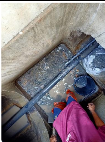
รูปที่ 2-33 การขุดลอกกระบะระบายน้ำ
