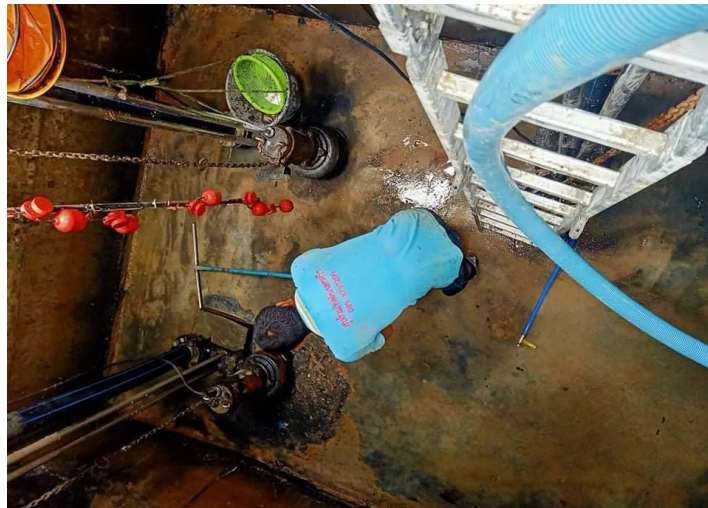
รูปที่ 3-5 การทำความสะอาดถังเก็บน้ำประปาของโครงการ
