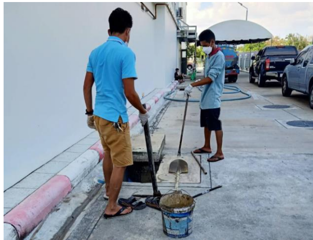
รูปที่ 2-10 รถเทศบาล เข้ามาสูบตะกอนส่วนเกินจากระบบบำบัดน้ำเสีย
