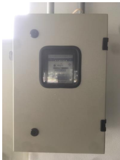
รูปที่ 2-12 การติดตั้งระบบควบคุม และมิเตอร์ไฟฟ้าสำหรับระบบบำบัดน้ำเสีย
