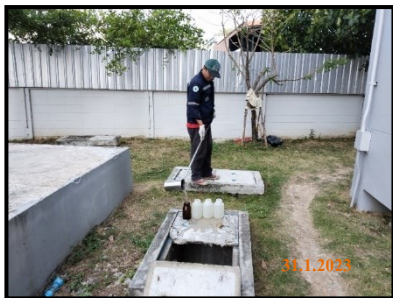
บ่อกักน้ำทิ้งหลังออกจากระบบบำบัดน้ำเสียรวม
