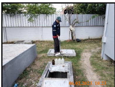
บ่อกักน้ำทิ้งหลังออกจากระบบบำบัดน้ำเสียรวม
