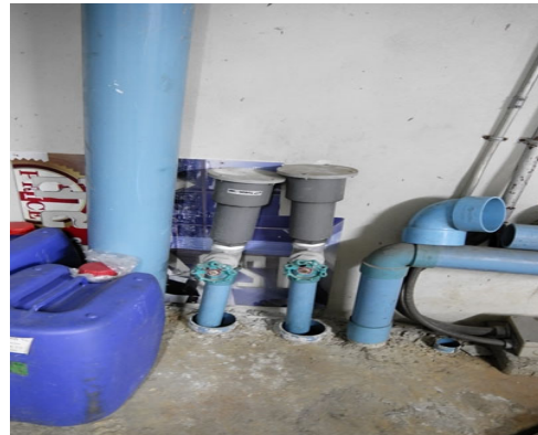
ภาพที่ 2.18 ท่อระบาย Gas ระบบบำบัดน้ำเสีย
