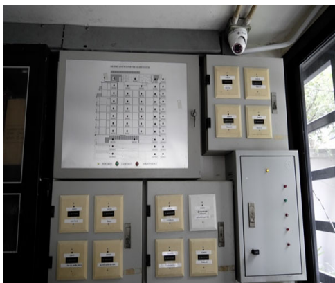
ภาพที่ 2.12 ตู้แสดงผลแจ้งเตือนกรณีเกิดเพลิงไหม้
