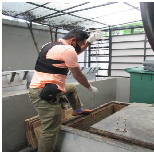
ภาพที่ 2.20 บ่อพักน้ำสุดท้าย และท่อระบายน้ำทิ้งจากระบบบำบัดน้ำเสีย โดยติดตั้งแรงดันในท่อ เพื่อกรองตะกอนและไขมันก่อนระบายออกนอกโครงการ
