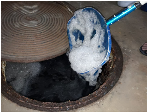
ภาพที่ 2.32 การตักไขมันจากบ่อบำบัดน้ำเสีย
