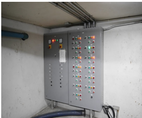
ภาพที่ 2.17 ตู้ควบคุมระบบบำบัดน้ำเสีย
