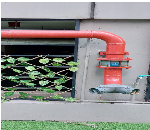
ภาพที่ 2.10 หัวรับน้ำดับเพลิงด้านหน้าอาคาร
