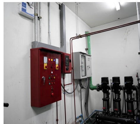
ภาพที่ 2.11 ตู้ควบคุมระบบดับเพลิง
