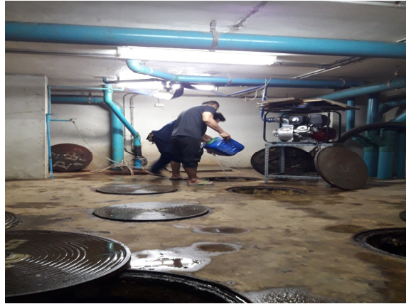
ภาพที่ 2.21 เจ้าหน้าที่ดูแลระบบบำบัดน้ำเสีย ทำความสะอาดตกไขมันและเติมจุลินทรีย์
