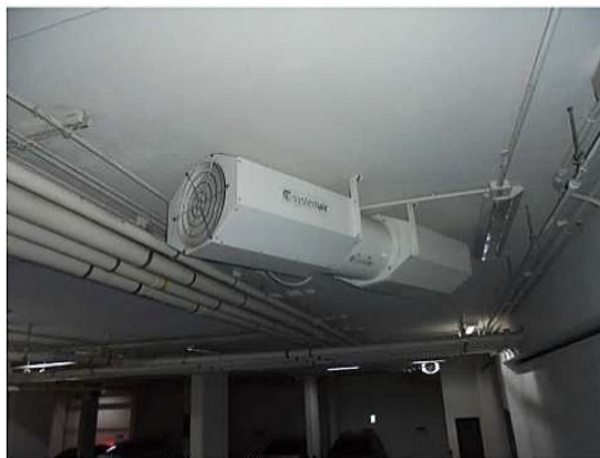
ภาพที่ 3-6 ที่จอดรถชั้นใต้ดิน และพัดลมระบายอากาศ
