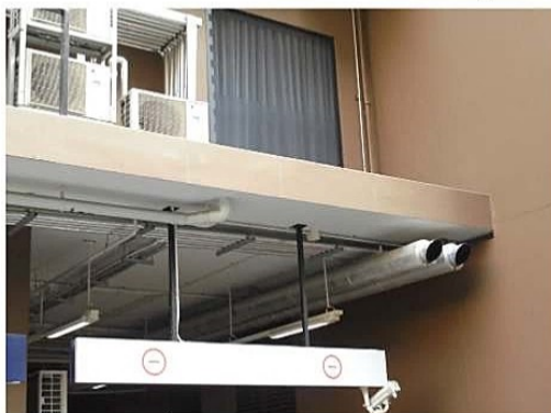
ภาพที่ 3-17 ท่อไอเสียจากห้องไฟฟ้าฉุกเฉิน ปล่อยออกมาตรงกับต้นไม้ยืนต้นข้างรั้วโครงการ
