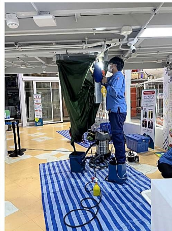
ภาพที่ 3-44 ล้างทำความสะอาดเครื่องปรับอากาศส่วนกลางประจำอาคาร
