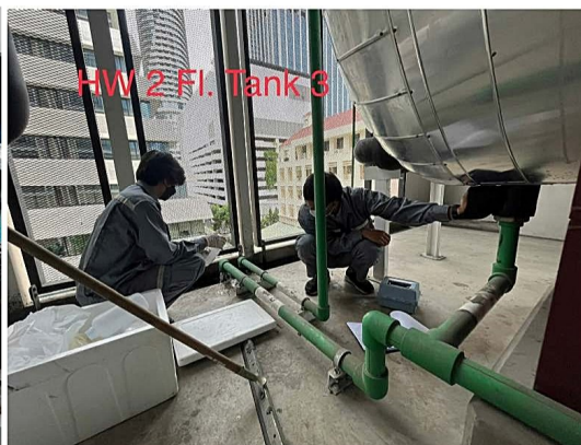
ภาพที่ 3-46 ตรวจสอบถังสำรองน้ำ วาล์วน้ำ ไม่มีจุดรั่วซึม
