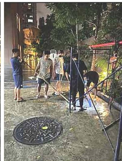
ภาพที่ 3-39 ดูดตะกอนจากระบบบำบัดน้ำเสีย และบำรุงรักษาอย่างสม่ำเสมอ
