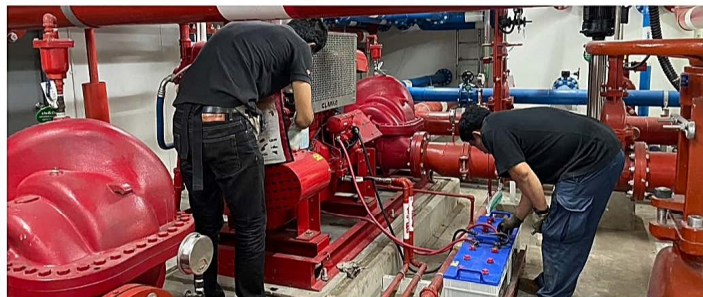
ภาพที่ 3-45 ตรวจสอบระบบป้องกันอัคคีภัยและเครื่องปั้มน้ำดับเพลิง
