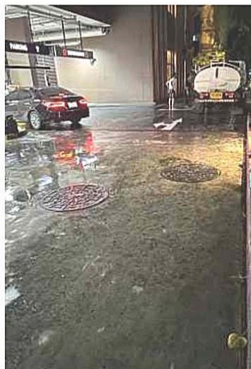
ภาพที่ 3-39 ดูดตะกอนจากระบบบำบัดน้ำเสีย และบำรุงรักษาอย่างสม่ำเสมอ
