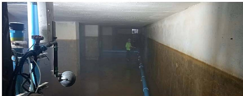
ภาพที่ 3-41 ล้างทำความสะอาดถังสำรองน้ำใช้
