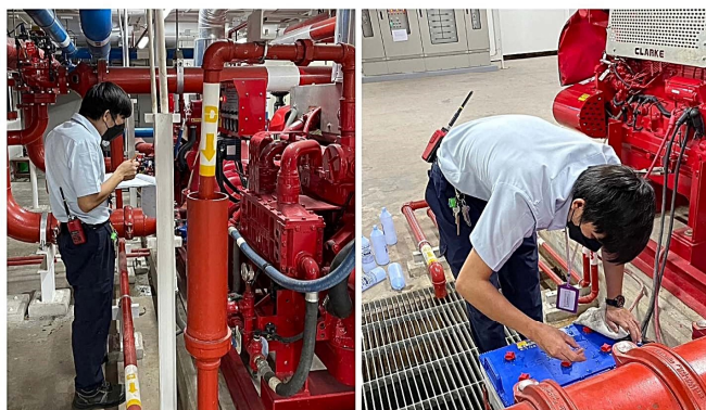
ภาพที่ 3-20 ห้องเครื่องสูบน้ำดับเพลิง และการตรวจสอบระบบ
