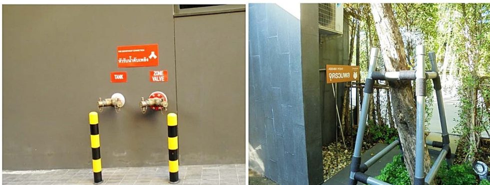
ภาพที่ 2-37 หัวรับน้ำดับเพลิงจากภายนอก และพื้นที่จุดรวมพลด้านหน้าทางเข้าออกโครงการ
