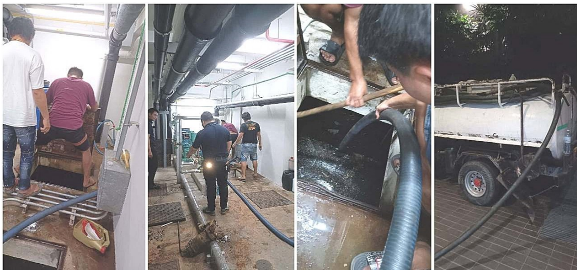
ภาพที่ 2-43 ดูแลรักษาระบบบำบัดน้ำเสีย ดูดตะกอนที่บ่อเก็บตะกอน
