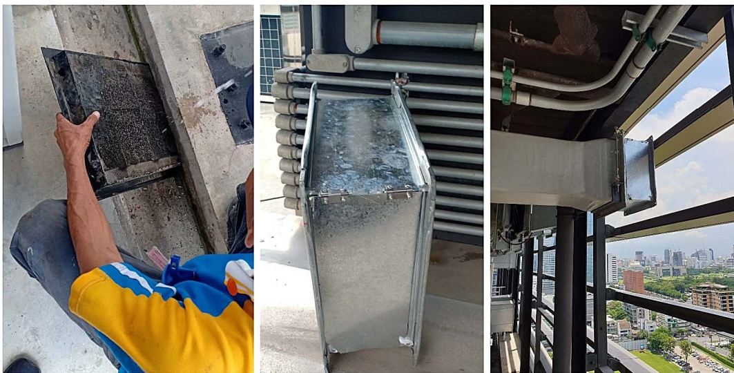
ภาพที่ 2-35 ติดตั้ง ถังบรรจุ Activated Carbon และแผ่น Filter สำหรับการบำบัด Aerosol และดูแลรักษาโดยถนอมแผ่น Filter นำมาล้าง
