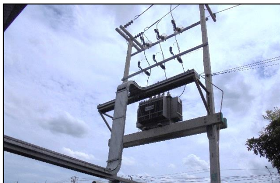
รูปที่ 77 หม้อแปลงไฟฟ้าภายในโครงการ
