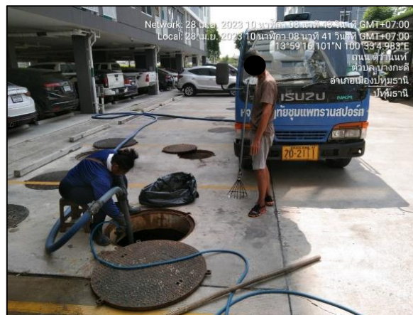
รูปที่ 25 เจ้าหน้าที่สูบล้างปลักอุด
