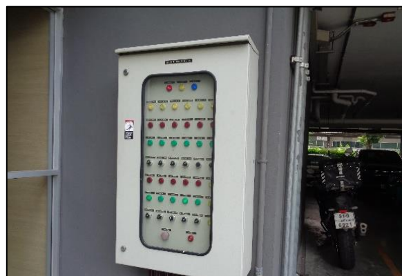
รูปที่ 26 ตู้ควบคุมระบบบำบัดน้ำเสีย
