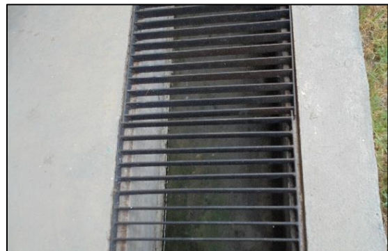
รูปที่ 67 ตะแกรงวางระบายน้ำรอบโครงการ
