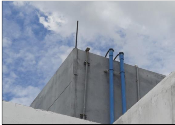
รูปที่ 21 ถังสำรองน้ำบนดาดฟ้า
