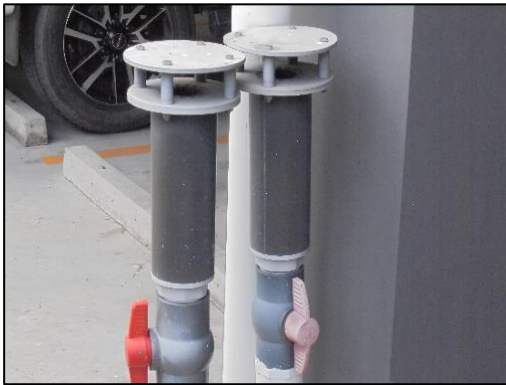
รูปที่ 28 เครื่องเติมอากาศระบบบำบัดน้ำเสีย
