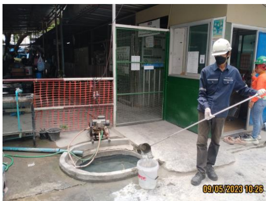
รูปที่ 3-27 บ่อน้ำทิ้งสุดท้ายก่อนระบายออกสู่ท่อระบายน้ำ ริมถนนพหลโยธิน
