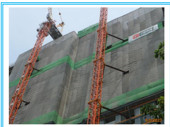
รูปที่ 3-9 Mesh Sheet ปิดคลุมอาคาร
