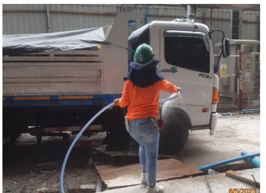
รูปที่ 3-16 ล้างล้อรถก่อนออกนอกพื้นที่โครงการ
