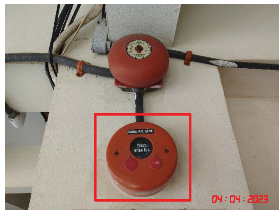
ระบบสัญญาณแจ้งเหตุเพลิงไหม้แบบใช้มือกด
