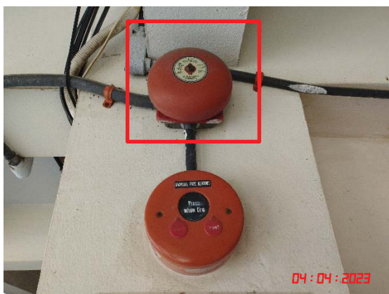
ระบบสัญญาณแจ้งเหตุเพลิงไหม้แบบกริ่ง
