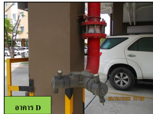
รูปที่ 45 หัวรับน้ำดับเพลิงภายในโครงการ
