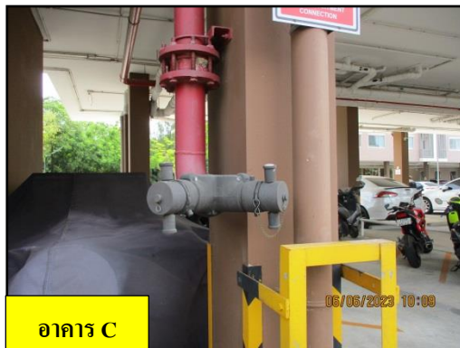
รูปที่ 45 หัวรับน้ำดับเพลิงภายในโครงการ
