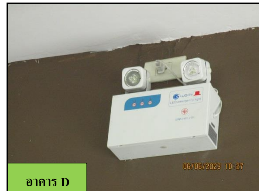
รูปที่ 33 ไฟส่องสว่างฉุกเฉิน
