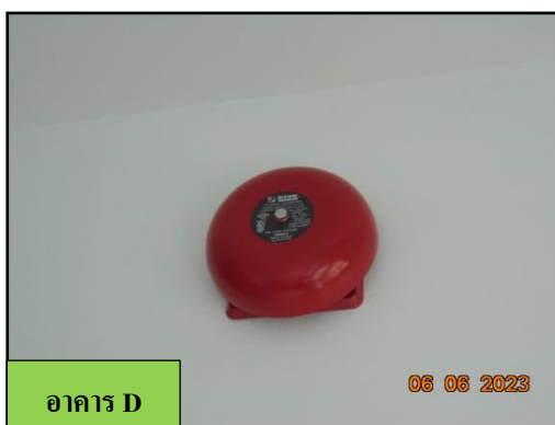
รูปที่ 27 เครื่องส่งสัญญาณไฟแบบกริ่ง (Alarm Bell) และอุปกรณ์แจ้งเหตุ (Switch Board)
