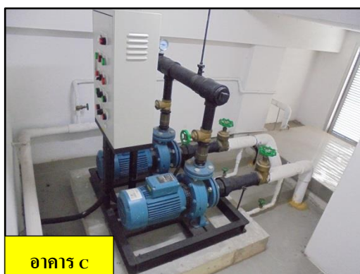
รูปที่ 17 ปั๊มดึงเก็บน้ำขึ้นใต้ดิน
