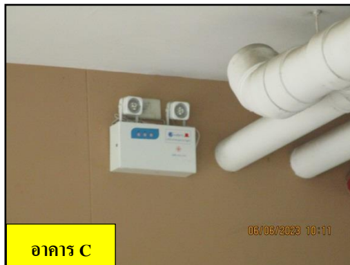
รูปที่ 33 ไฟส่องสว่างฉุกเฉิน
