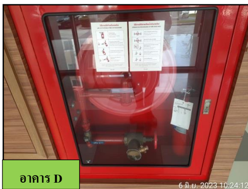
รูปที่ 32 ตู้สายฉีดน้ำดับเพลิง และถังดับเพลิงแบบมือถือ
