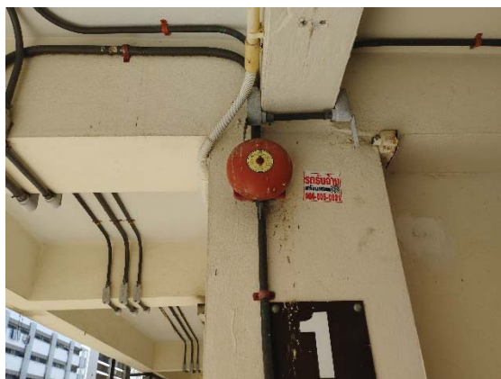
สัญญาณเตือนเพลิงไหม้แบบกริ่ง
