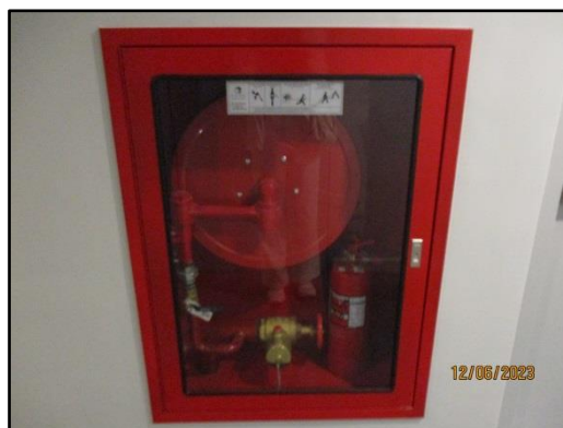
รูปที่ 41 ตู้เก็บสายฉีดดับเพลิง
