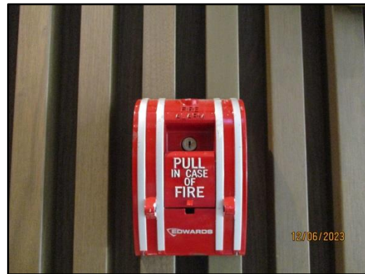
รูปที่ 43 อุปกรณ์เตือนภัยแบบใช้มือดึง
