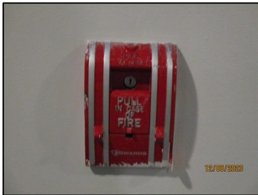
รูปที่ 43 อุปกรณ์เตือนภัยแบบใช้มือดึง
