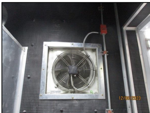
รูปที่ 12 พัดลมสำหรับระบายอากาศ
