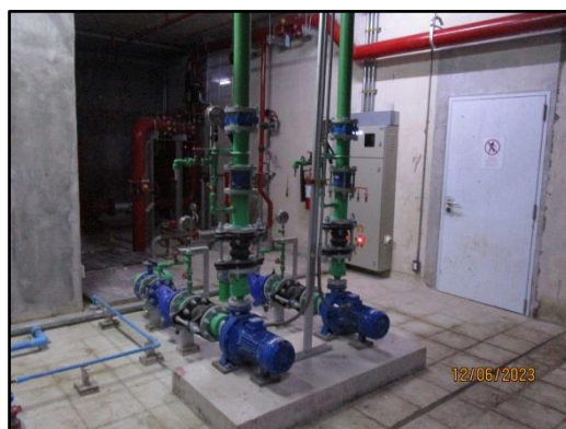
รูปที่ 17 ระบบเครื่องปั้มน้ำใช้ในโครงการ
