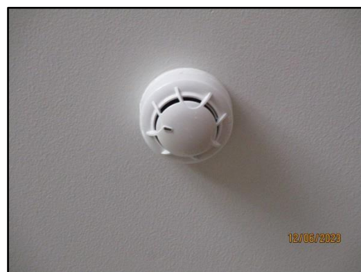
รูปที่ 45 อุปกรณ์ตรวจจับควัน
