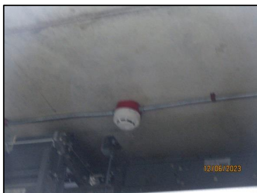
รูปที่ 31 Smoke Detector ในห้อง MDB
