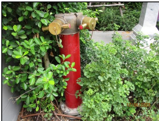
รูปที่ 40 หัวจ่ายรับน้ำดับเพลิงโครงการ
