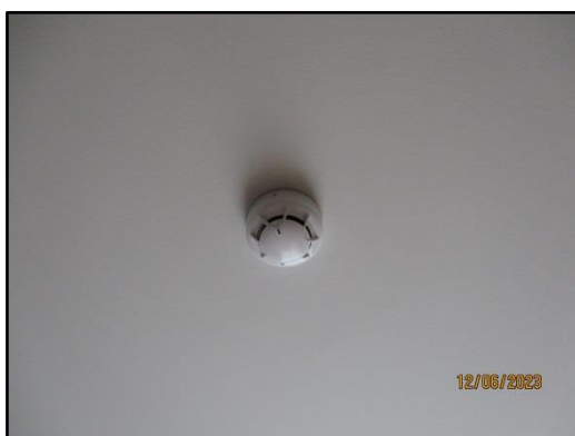
รูปที่ 45 อุปกรณ์ตรวจจับควัน
