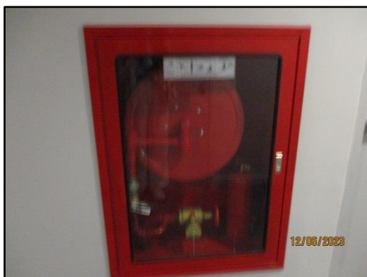
รูปที่ 41 ตู้เก็บสายฉีดดับเพลิง
