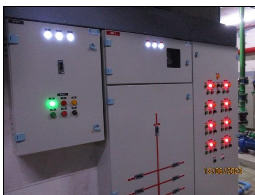
รูปที่ 21 ตู้ควบคุมระบบบำบัดน้ำเสีย
