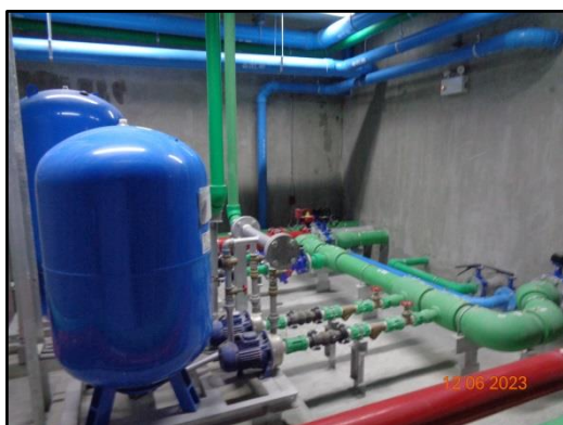
รูปที่ 17 ระบบเครื่องปั้มน้ำใช้ในโครงการ
