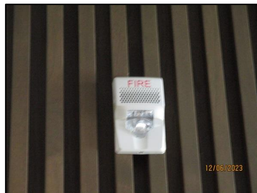
รูปที่ 44 อุปกรณ์เตือนภัยแบบใช้แสงและเสียง
