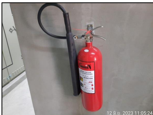
รูปที่ 42 ถังดับเพลิงแบบมือถือ
