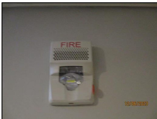
รูปที่ 44 อุปกรณ์เตือนภัยแบบใช้แสงและเสียง
