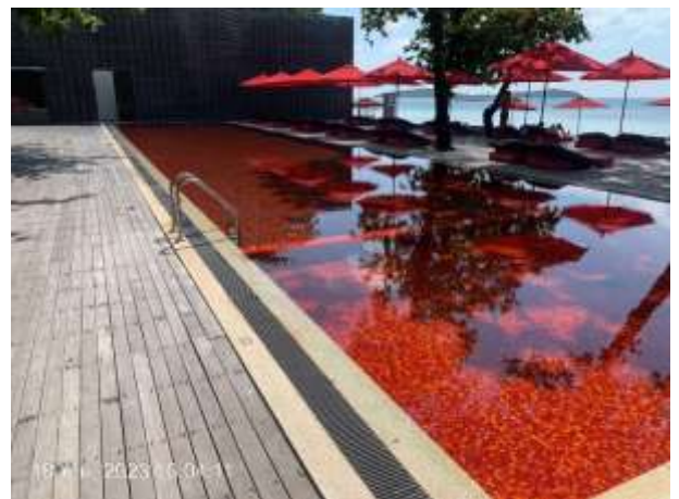
รูปที่ 22 รางระบายน้ำล้นรอบสระว่ายน้ำ
