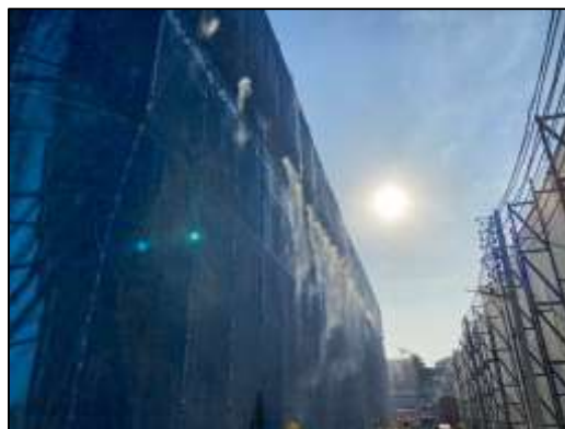
ภาพที่ 21 สเปรย์น้ำบนโครงสร้าง Mesh Sheet ชั้น 3 ด้านทิศใต้และทิศตะวันตก
