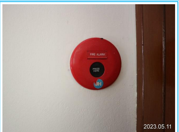
รูปที่ 3-53 สัญญาณเตือนภัยด้วยมือ
