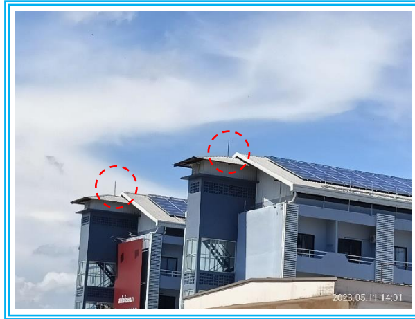
รูปที่ 3-64 ระบบป้องกันอันตรายจากฟ้าผ่า
