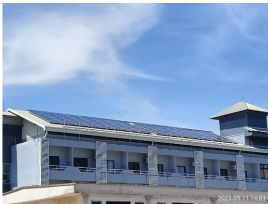
รูปที่ 2.3-9 ติดตั้งแผงโซลาร์เซลล์
