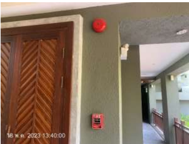
รูปที่ 23 อุปกรณ์ส่งสัญญาณเตือนเกิดอัคคีภัย
