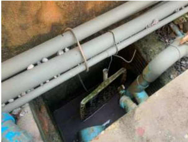
รูปที่ 13 ตะแกรงดักขยะบ่อสุดท้ายก่อนลงทะเล
