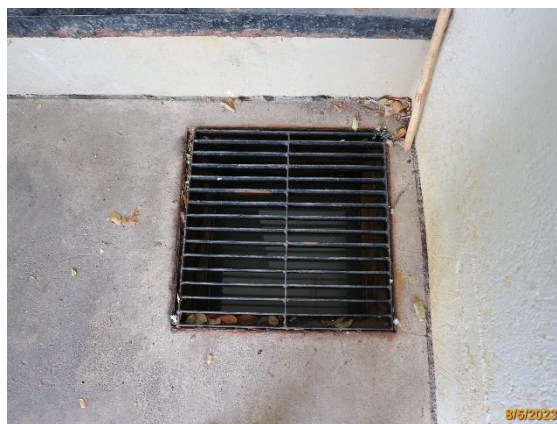
รูปที่ 2.12-21 บ่อพักน้ำรองรับน้ำชะขยะ
