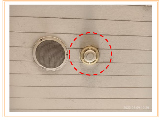
รูปที่ 2.10-2 Smoke Detector ภายในอาคาร
