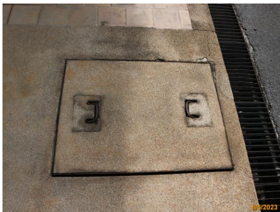
บ่อดักน้ำติดตั้งอยู่เป็นระยะ
