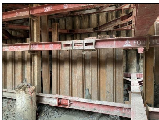
รูปที่ 7 กำแพงเสาเข็มเจาะระบบค้ำยันป้องกันดินพัง
