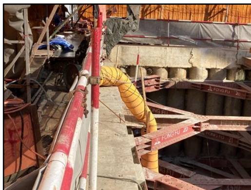
รูปที่ 68 พัฒนพร้อมท่อระบายอากาศเป่าระบายอากาศเข้าพื้นที่อับอากาศ
