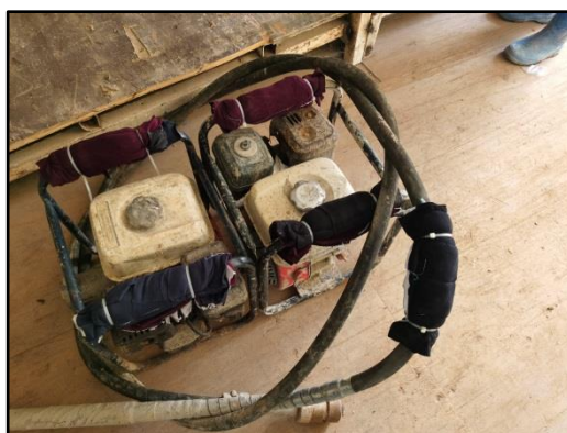
รูปที่ 36 ใช้วัสดุอุดห้ความสั่นสะเทือนเพื่อป้องกันความสั่นสะเทือนจากวัสดุอุปกรณ์ก่อสร้าง
