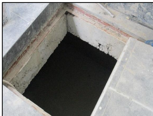
รูปที่ 42 บ่อระบายน้ำที่ก่อก่อนระบายออกสู่ท่อระบายน้ำสาธารณะ
