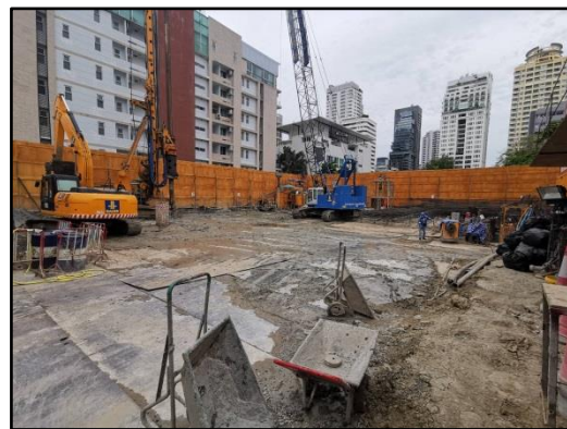
รูปที่ 32 ใช้เสาเข็มแบบเจาะ
