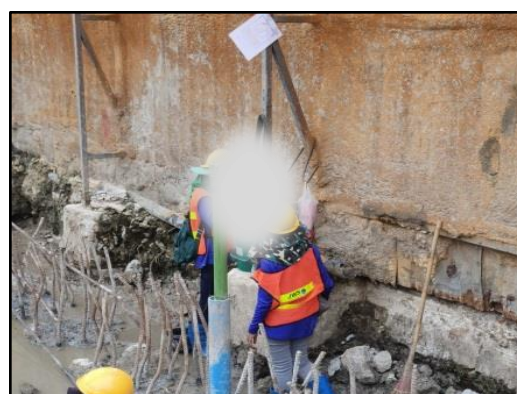
รูปที่ 9 ติดตั้งอุปกรณ์วัดการเคลื่อนตัวของดิน
