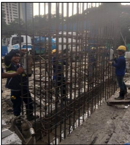
รูปที่ 27 การก่อสร้างกำแพงกันดิน (D-Wall)
