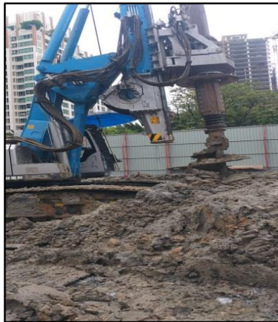
รูปที่ 23 การใช้เสาเข็มแบบเจาะในการก่อสร้างเพื่อลดผลกระทบด้านเสียงและการสั่นสะเทือน
