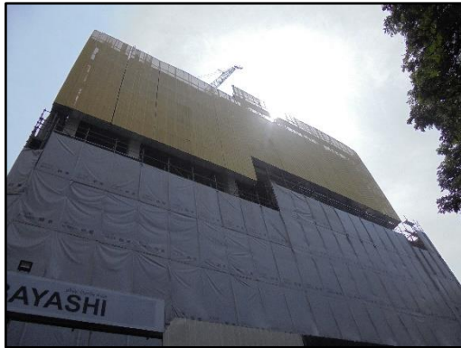
รูปที่ 12 ผ้าใบกันฝุ่นคลุมอาคาร
