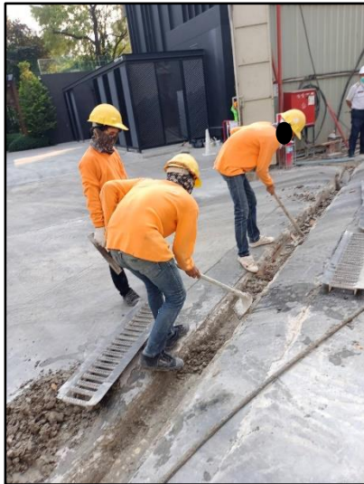
รูปที่ 36 เจ้าหน้าที่ดูแลขุดลอกตะกอนที่สะสมในท่อระบายน้ำชั่วคราว
