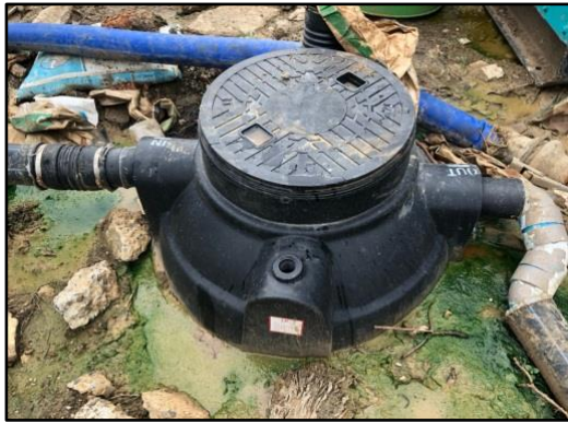
รูปที่ 30 ระบบบำบัดน้ำเสียสำเร็จรูป
