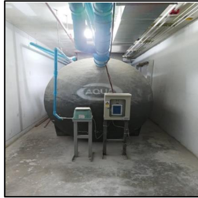
รูปที่ 30 ระบบบำบัดน้ำเสียสำเร็จรูป
