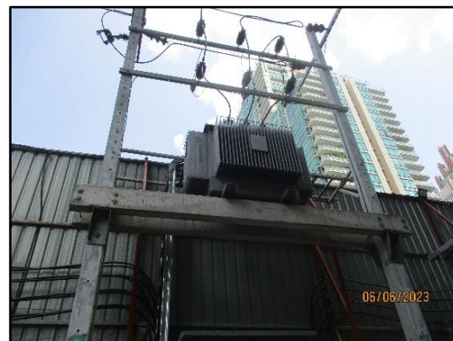
รูปที่ 47 หม้อแปลงไฟฟ้าในพื้นที่โครงการ
