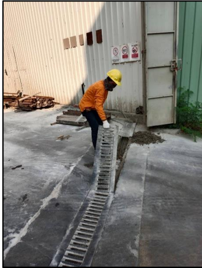
รูปที่ 35 ท่อระบายน้ำชั่วคราว โดยรอบพื้นที่โครงการ
