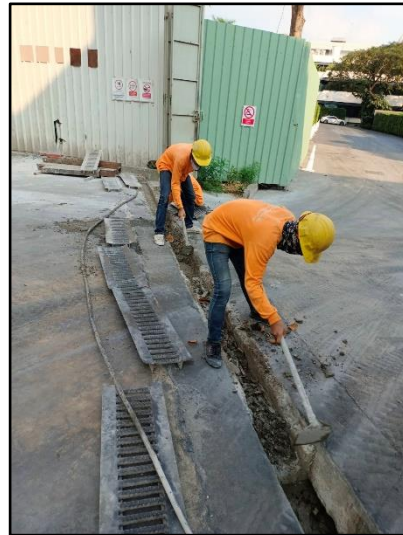
รูปที่ 36 เจ้าหน้าที่ดูแลขุดลอกตะกอนที่สะสมในท่อระบายน้ำชั่วคราว
