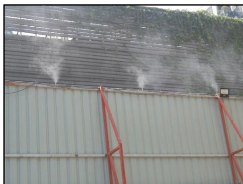
รูปที่ 3 นีดสปริงเกอร์และนิตพรมน้ำบริเวณก่อสร้างหรือบริเวณที่ทำให้เกิดฝุ่น
