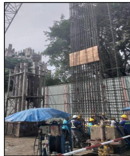
รูปที่ 27 การก่อสร้างกำแพงกันดิน (D-Wall)
