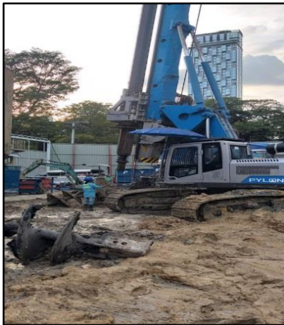
รูปที่ 23 การใช้เสาเข็มแบบเจาะในการก่อสร้างเพื่อลดผลกระทบด้านเสียงและการสั่นสะเทือน
