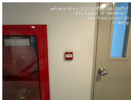
รูปที่ 31 อุปกรณ์แจ้งเหตุเพลิงไหม้แบบใช้มือ
