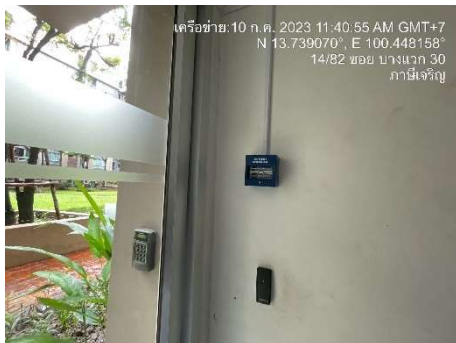
รูปที่ 21 ระบบเปิดประตูทางออกเมื่อเกิดเหตุฉุกเฉินเท่านั้น
