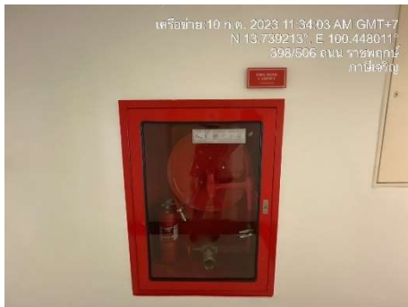
รูปที่ 36 (ต่อ) ตู้เก็บสายฉีดน้ำดับเพลิง
