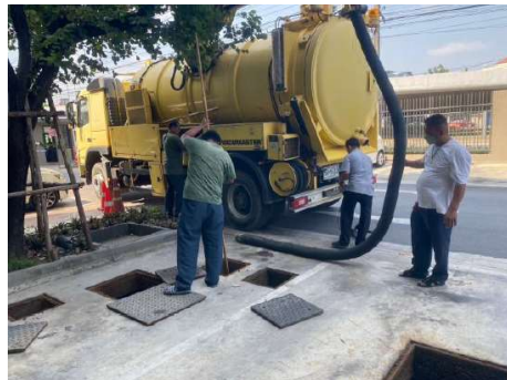
รูปที่ 56 การสูบน้ำจากตะกอนจากระบบบำบัดน้ำเสีย
