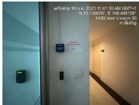
รูปที่ 21 ระบบเปิดประตูทางออกเมื่อเกิดเหตุฉุกเฉินเท่านั้น
