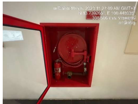
รูปที่ 36 (ต่อ) ตู้เก็บสายฉีดน้ำดับเพลิง
