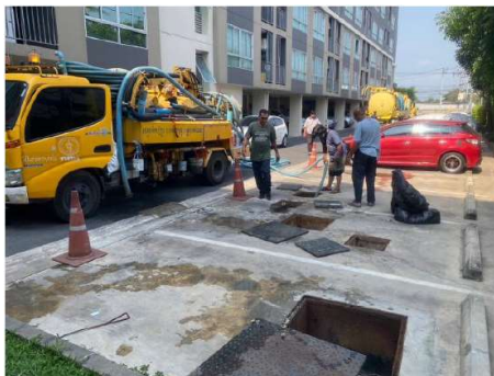
รูปที่ 56 การสูบน้ำจากตะกอนจากระบบบำบัดน้ำเสีย
