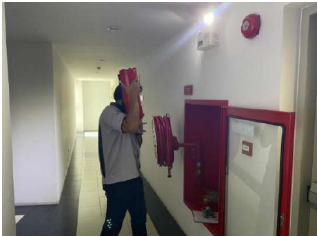
รูปที่ 60 การตรวจสอบประสิทธิภาพของอุปกรณ์สำหรับดับเพลิง
