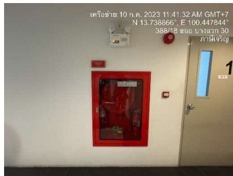
รูปที่ 36 ตู้เก็บสายฉีดน้ำดับเพลิง
