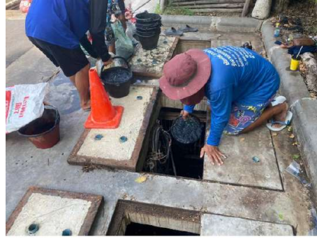
รูปที่ 58 การขุดลอกเศษตะกอนในท่อระบายน้ำ
