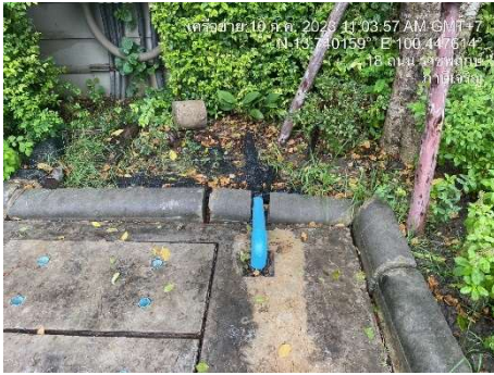
รูปที่ 12 ระบบน้ำทิ้งที่ผ่านการบำบัดแล้วมาใช้รดน้ำต้นไม้
