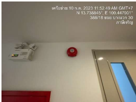
รูปที่ 32 อุปกรณ์ส่งสัญญาณเตือนเพลิงไหม้
