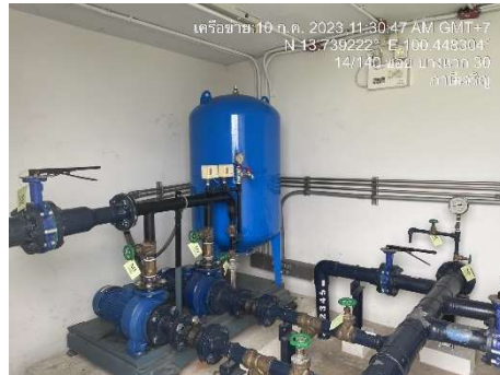
รูปที่ 18 ปั๊มและถังเก็บน้ำบนชั้นหลังคา
