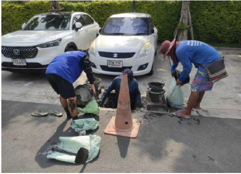
รูปที่ 58 การขุดลอกเศษตะกอนในท่อระบายน้ำ
