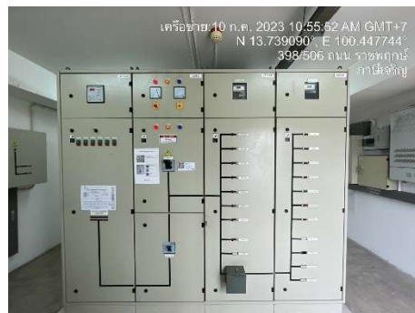
รูปที่ 11 มิเตอร์ไฟฟ้าของส่วนระบบบำบัดน้ำเสีย
