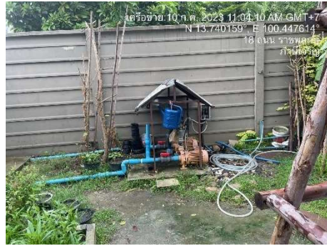
รูปที่ 12 ระบบน้ำทิ้งที่ผ่านการบำบัดแล้วมาใช้รดน้ำต้นไม้
