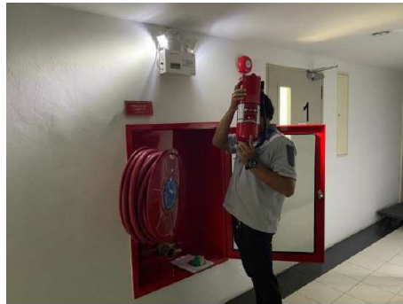
รูปที่ 60 การตรวจสอบประสิทธิภาพของอุปกรณ์สำหรับดับเพลิง
