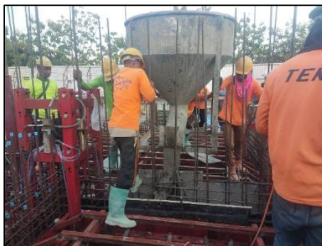
รูปที่ 72 พนักงานเทคอนกรีต
