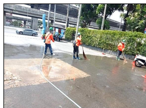
รูปที่ 11 ติดตั้งสปริงเกอร์ และฉีดพรมน้ำบริเวณพื้นที่ก่อสร้าง หรือบริเวณที่ทำให้เกิดฝุ่น
