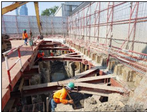
รูปที่ 38 ระบบค้ำยัน และระบบป้องกันดินพัง
