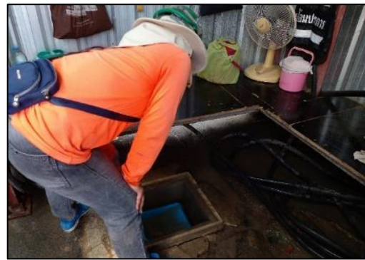
รูปที่ 48 เจ้าหน้าที่ตรวจสอบปริมาณตะกอนดินในบ่อพัก และขุดลอกอย่างสม่ำเสมอ
