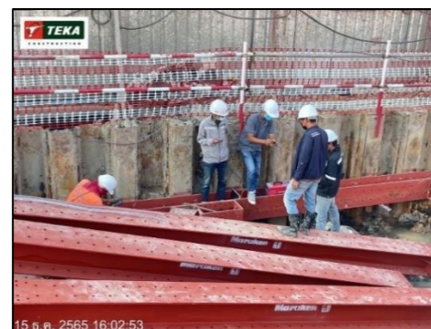
รูปที่ 39 วิศวกรควบคุมการออกแบบระบบค้ำยัน และควบคุมการก่อสร้างอย่างใกล้ชิด
