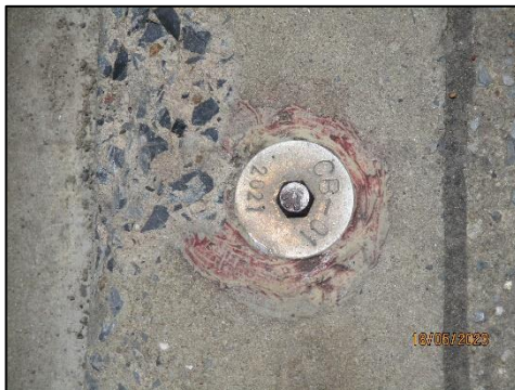
รูปที่ 68 หมุดระดับ และพิกัดอ้างอิงภายในพื้นที่ก่อสร้าง
