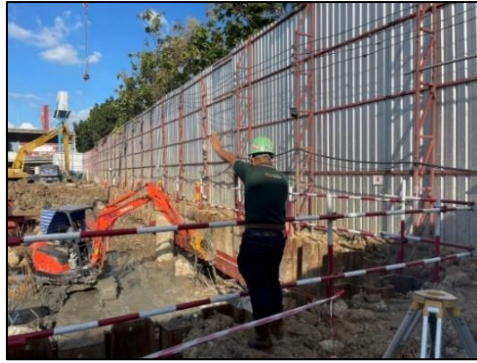
รูปที่ 40 วิศวกรควบคุมตรวจสอบเสถียรภาพของงานขุดดิน
