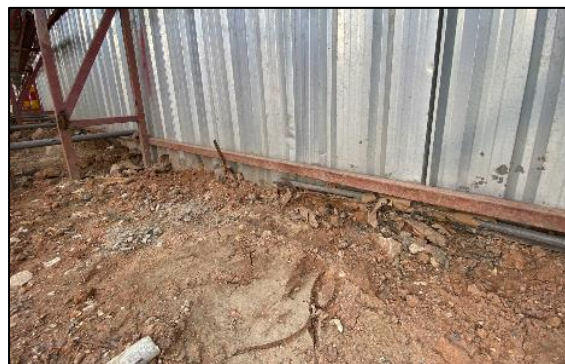
รูปที่ 52 รื้อแนวกันดินจากโครงการ และป้องกันการระบายน้ำไปยังพื้นที่ข้างเคียง
