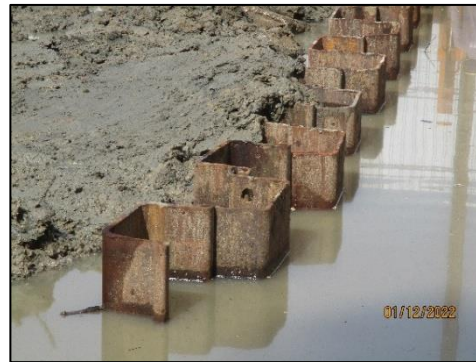
รูปที่ 38 ระบบค้ำยัน และระบบป้องกันดินพัง
