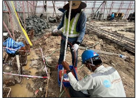
รูปที่ 43 ติดตั้งเครื่องมือตรวจวัดการเอียงตัว
