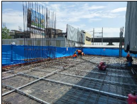
รูปที่ 71 เตรียมพื้นที่ก่อนเทคอนกรีต
