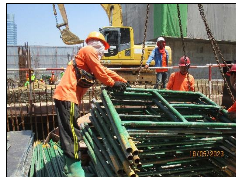
รูปที่ 87 การลงวัสดุก่อสร้างต้องกระทำด้วยความระมัดระวัง และมีวัสดุรองรับเพื่อหลีกเลี่ยงการกระแทก
