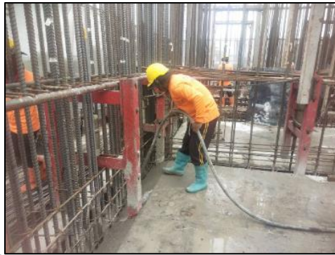
รูปที่ 75 พนักงานฉีดเชย่าคอนกรีต
