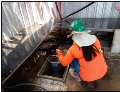
รูปที่ 48 เจ้าหน้าที่ตรวจสอบปริมาณตะกอนดินในบ่อพัก และขุดลอกอย่างสม่ำเสมอ
