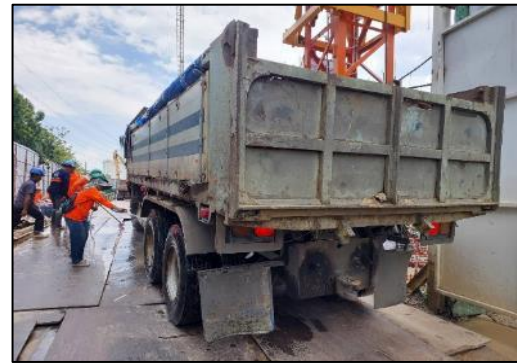
รูปที่ 14 ทำความสะอาดล้อรถบรรทุกก่อนออกจากโครงการ
