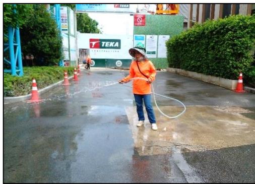
รูปที่ 11 ติดตั้งสปริงเกอร์ และฉีดพรมน้ำบริเวณพื้นที่ก่อสร้าง หรือบริเวณที่ทำให้เกิดฝุ่น
