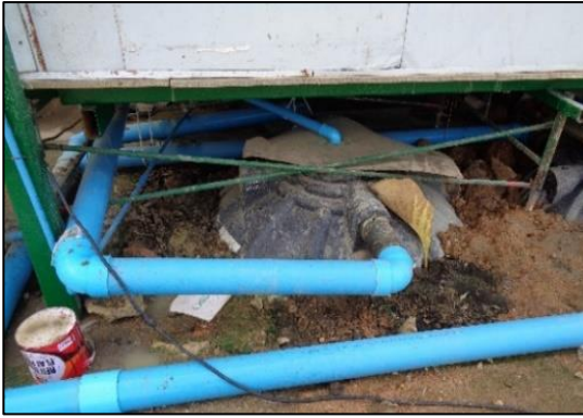
รูปที่ 45 ถังบำบัดน้ำเสียสำเร็จรูป
