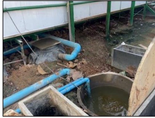
รูปที่ 45 ถังบำบัดน้ำเสียสำเร็จรูป
