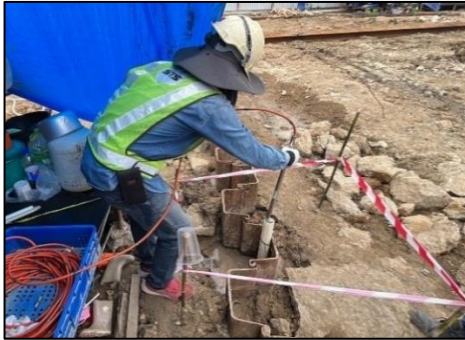
รูปที่ 43 ติดตั้งเครื่องมือตรวจวัดการเอียงตัว
