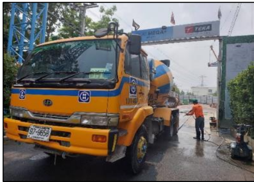
รูปที่ 14 ทำความสะอาดล้อรถบรรทุกก่อนออกจากโครงการ
