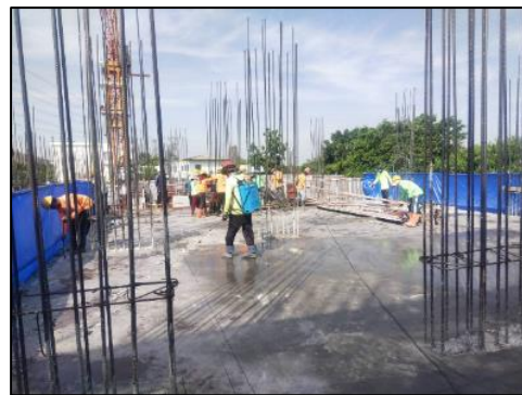
รูปที่ 76 พนักงานทำการบ่มคอนกรีต ด้วยการฉีดพ่นน้ำยา
