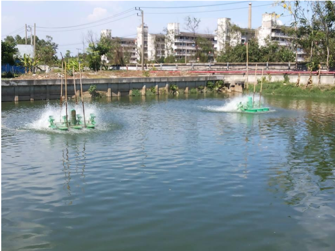
ภาพที่ 3-5 บ่อเติมอากาศ (Aeration Pond)
