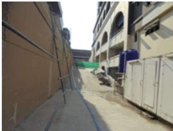
4-17 รื้อถอนรั้วเดิมบางส่วนเพื่อสร้างใหม่และกันสแลนเพื่อป้องกันผลกระทบด้านฝุ่นละออง
