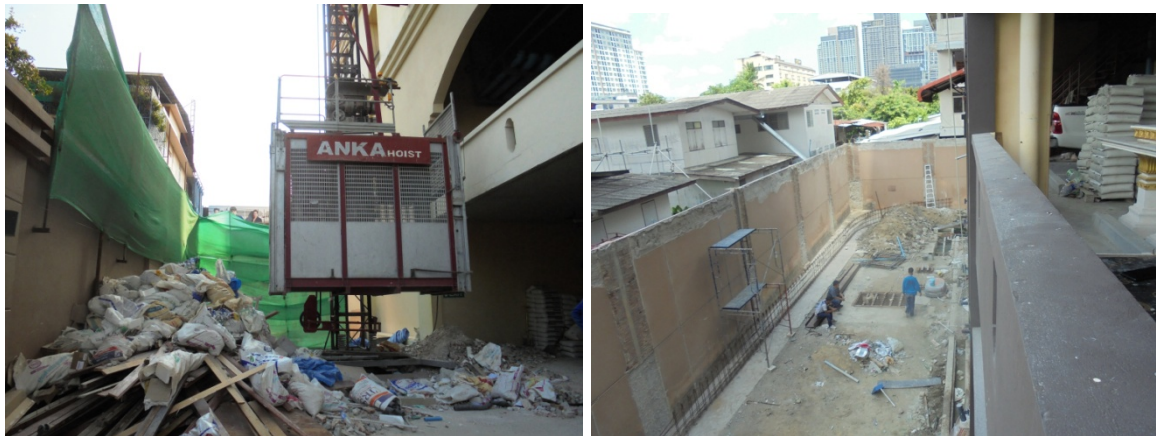
4-7 บริเวณรอบลิฟต์ชั้นของ ปิดสแลนป้องกันฝุ่นละอองไว้ด้านที่ติดกับอาคารข้างเคียง ปัจจุบันนำลิฟท์ออกแล้ว
