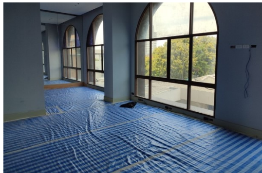
ภาพที่ 4-31 ปูผ้าใบป้องกันพื้นที่ทำเสร็จแล้วมีรอยและป้องกันฝุ่นละออง
