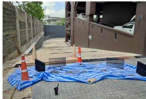
ภาพที่ 4-31 ปูผ้าใบป้องกันพื้นที่ทำเสร็จแล้วมีรอยและป้องกันฝุ่นละออง
