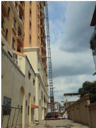
4-20 ลิฟต์ขนส่งของเพื่าลดความสูงของอาคาร ปัจจุบันนำออกแล้ว
