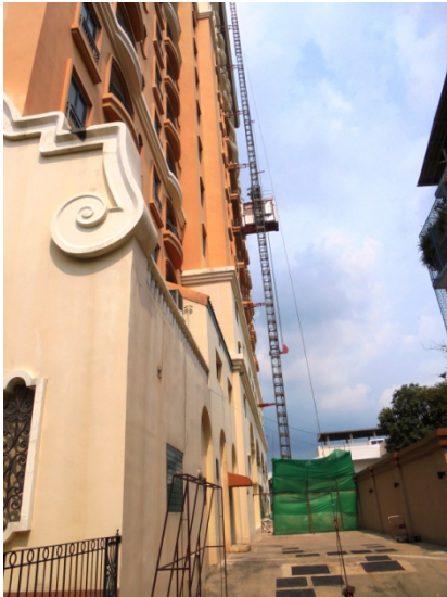
4-5 ติดตั้งลิฟต์ขนส่งของไว้ด้านทิศตะวันออกของอาคาร
