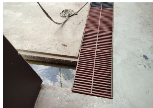
ภาพที่ 4-32 ขุดลอกตะกอนที่บ่อบำบัดน้ำและวางระบายน้ำ ไม่มีเศษวัสดุอุดตัน
