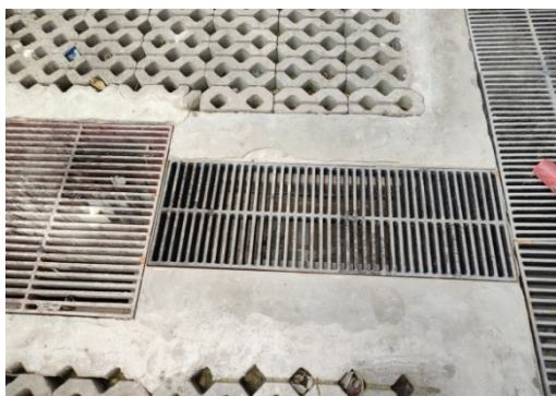
ภาพที่ 4-32 ขุดลอกตะกอนที่บ่อบำบัดน้ำและวางระบายน้ำ ไม่มีเศษวัสดุอุดตัน
