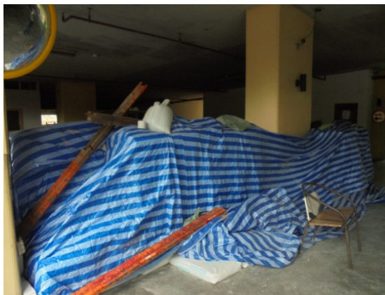
4-11 ใช้ผ้าปิดคลุมวัสดุที่จะทำให้เกิดฝุ่นละออง เช่น ปูนซีเมนต์ชนิดผง
