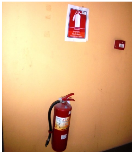
4-23 ติดตั้งเคมีดับเพลิงไว้แต่ละชั้น
