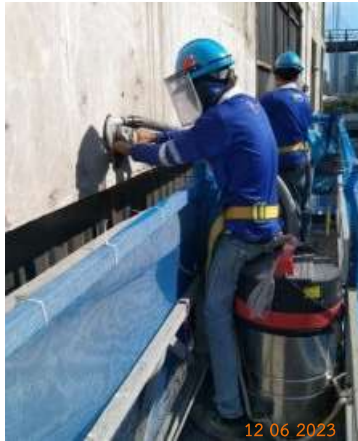
รูปที่ 2-65 การใช้เครื่องดูดฝุ่นที่แหล่งกำเนิด
