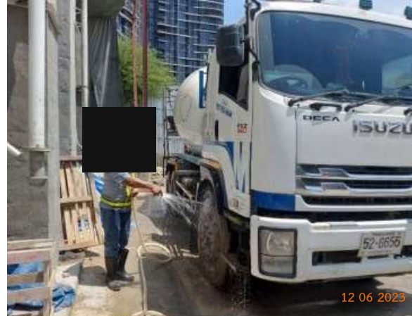
รูปที่ 2-10 การล้างล้อรถบรรทุก
