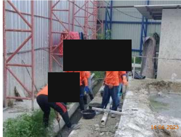
รูปที่ 2-27 การลอกวางระบายน้ำและบ่อดักตะกอน
