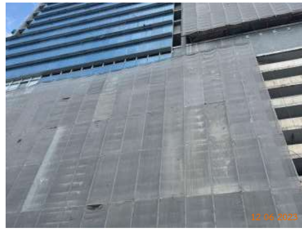
รูปที่ 2-64 การติดตั้ง Mesh Sheet (แบบกันไฟลาม)
