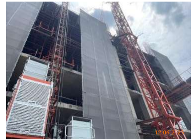
รูปที่ 2-64 การติดตั้ง Mesh Sheet (แบบกันไฟลาม)
