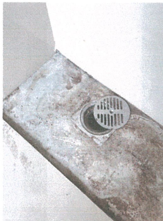
รูปภาพที่ 2.35 ท่อระบายน้ำเสียจากห้องพักขยะ
