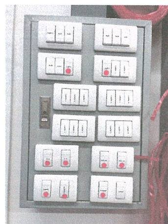
รูปภาพที่ 2.19 สวิตช์ควบคุมอุปกรณ์ไฟฟ้าแสงสว่าง
