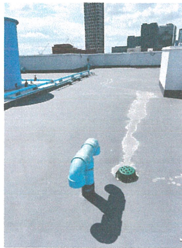
รูปภาพที่ 2.51 ท่อระบายน้ำที่มีเศษจากท่อกระโระ
