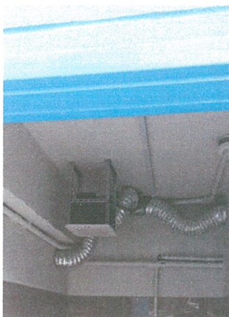
รูปภาพที่ 2.18 พัดลมดูดอากาศ
