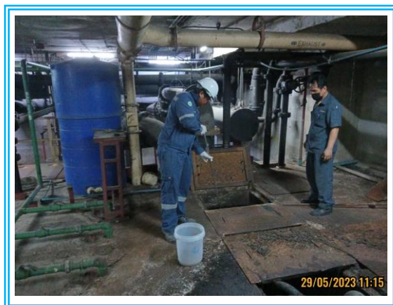
บ่อ Aerated Grit Chamber (ก่อนผ่านระบบฯ) เก็บตัวอย่างในวันที่ 29 พฤษภาคม 2566
