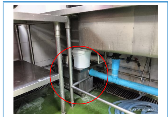
รูปที่ 3-11 ถังดักไขมันบริเวณห้องครัวของโรงแรม
