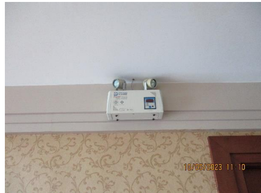
รูปที่ 3-55 ไฟส่องสว่างฉุกเฉิน
