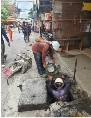
รูปที่ 3-14 การลอกท่อระบายน้ำของโครงการ
