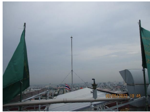
รูปที่ 3-37 ฐานหล่อฟ้าของอาคาร
